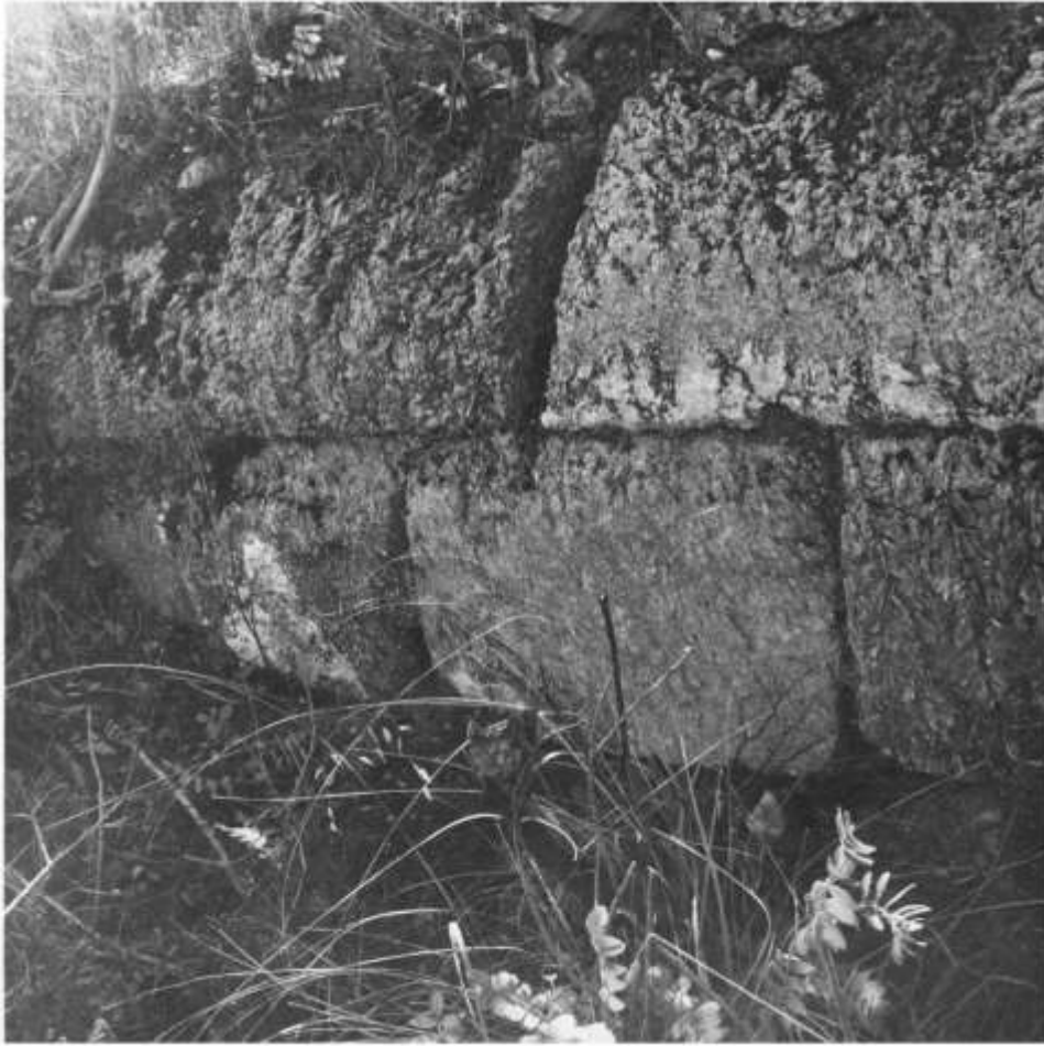
Fig. 50a. Ramacca, contrada La Montagna: apparecchio murario in opera trapezoidale della cinta di fortificazione (da Archivio della Soprintendenza di Siracusa).
