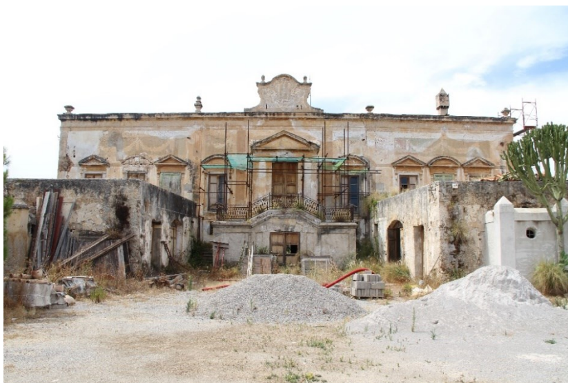
Figure 38 Villa Lampedusa – ingresso. Foto ritraente l'edificio prima dei lavori di messa in sicurezza e restauro
