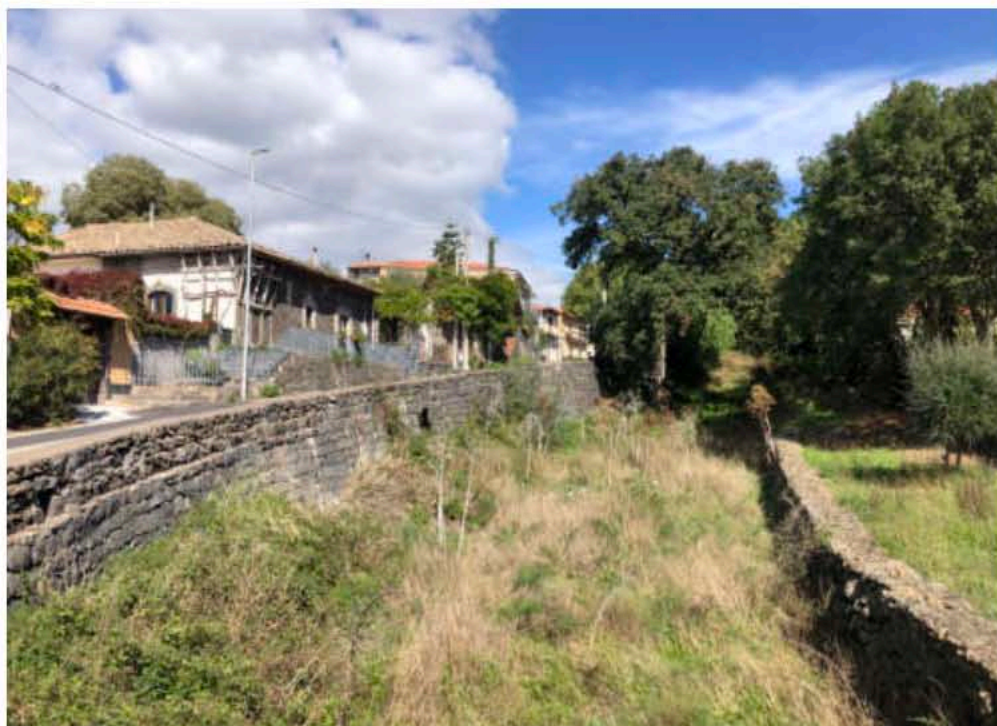
1. L'incisione del torrente Rosario che attraversa il centro abitato di Ragalna (Fonte: autori)
