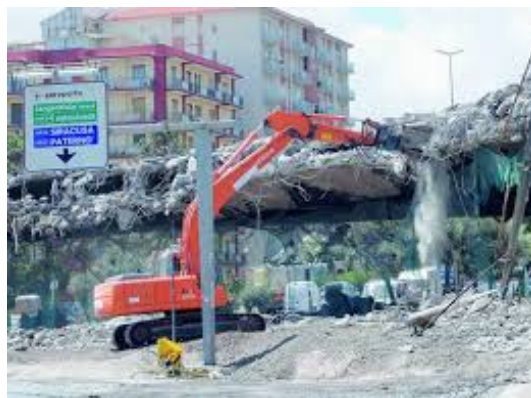
Fig. 4.1 - Una fase della demolizione del sovrappasso stradale 'Gioeni'.
