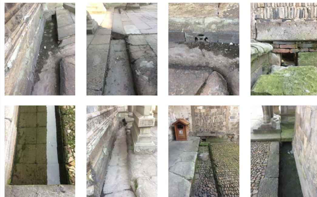
Dettagli del sistema delle corti legato alle acque piovane. Viaggio studio in Cina, Dongyang 2019.
