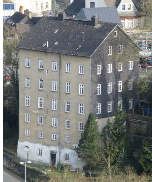
Haus Rath, edificio di 6 piani (5 più il pian terreno) alto circa 20 metri, i muri portanti sono spessi dai 75 ai 40 cm, costruito su un pendio a Weilburg/Lahn, in Germania, da Jacob Wimpf nel 1837. L'edificio è il più alto mai costruito in pisé in Europa. Non è stato possibile costruirne di più alti perché i regolamenti edilizi posteriori non lo consentono. È l'esempio vivente della durezza e della solidità delle costruzioni in terra cruda.
