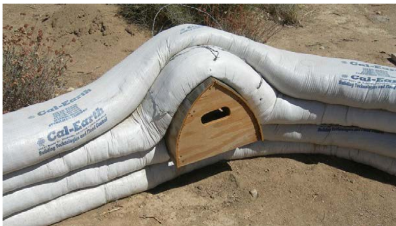
A sinistra. Cantiere della Call-Earth in California ad Hesperia. foto di London Permaculture. www.ourworld.unu.edu
