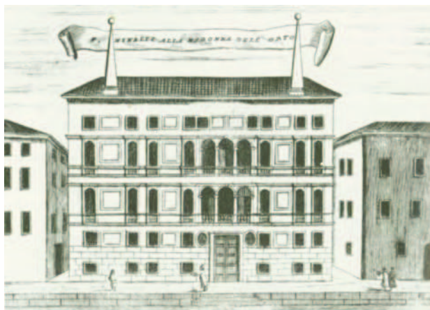
Fig. 109. Palazzo Minelli, prospetto sul canale di Cannaregio, illustrazione di V. Coronelli del 1709, in Peter Eisenman, "Palazzo Minelli, Venezia".
