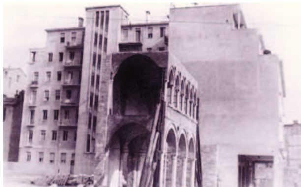
Fig. 258. Veduta di Casa Vietti dopo le demolizioni del quartiere Cortesella e dopo il restauro eseguito da Terragni nel 1941.
