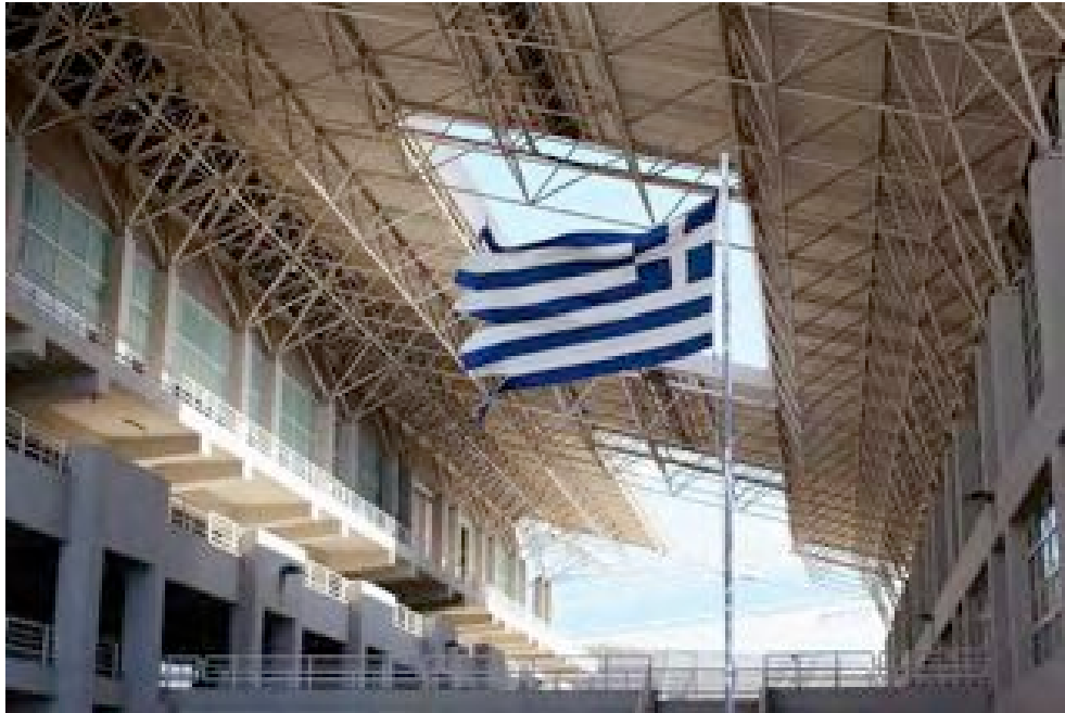
2012, Decadimento di impianti olimpici
