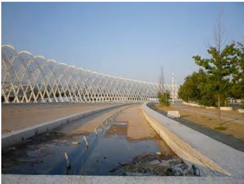
2012, Decadimento di impianti olimpici
