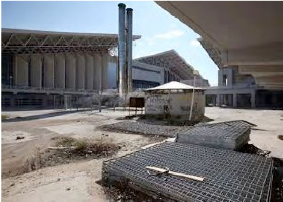
2012, Decadimento di impianti olimpici
