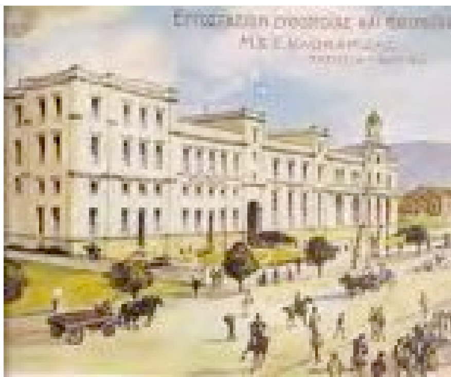
1930, Atene, quartiere Ano Patisia - Complesso di una fabbrica
