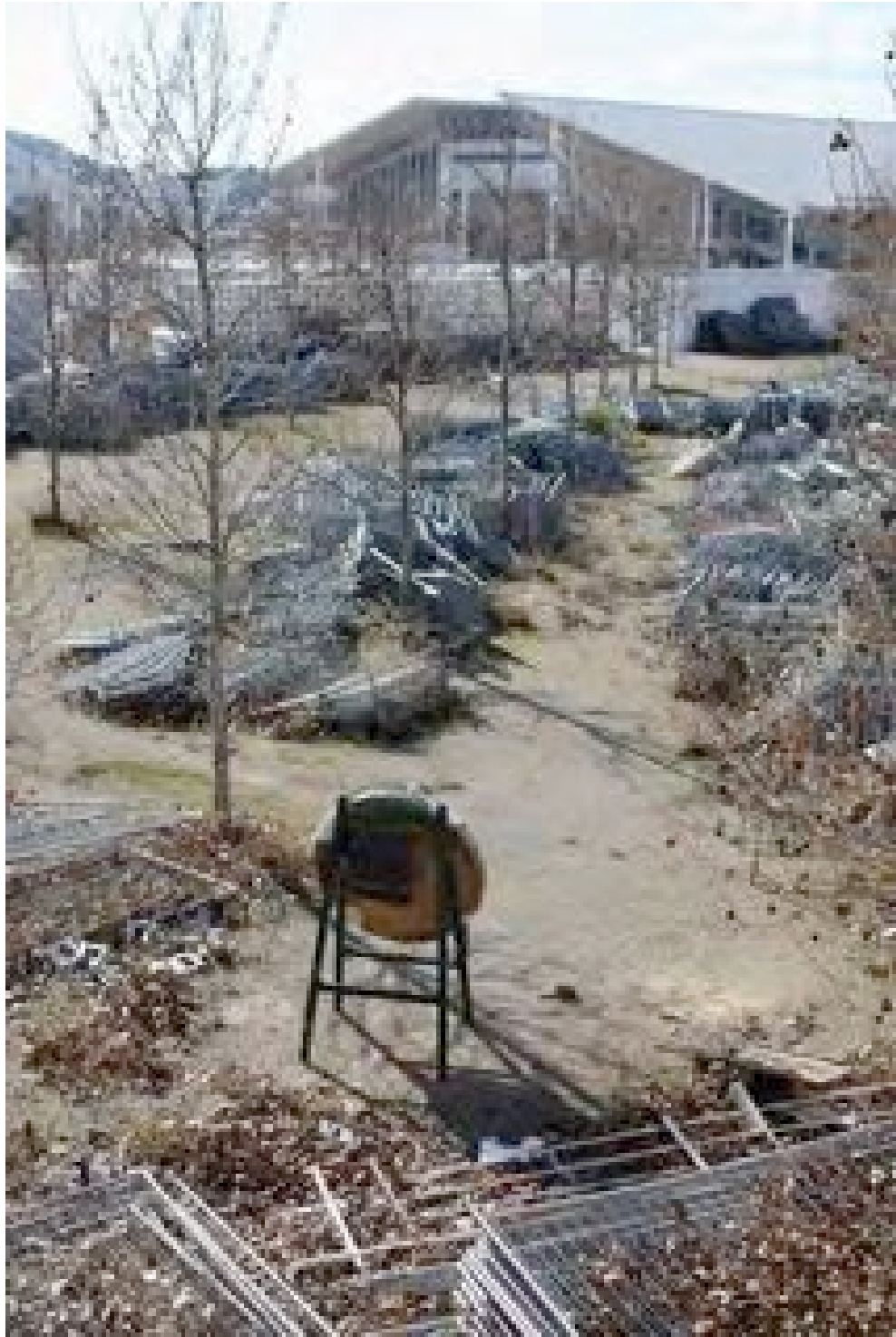
2012, Decadimento di impianti olimpici
