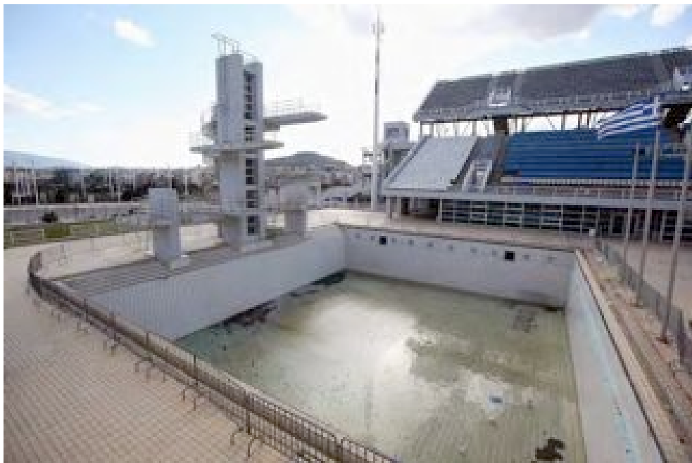
2012, Decadimento di impianti olimpici
