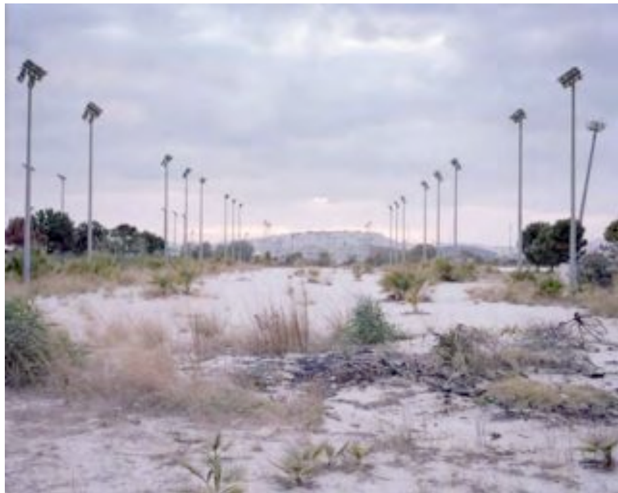
2012, Decadimento di impianti olimpici
