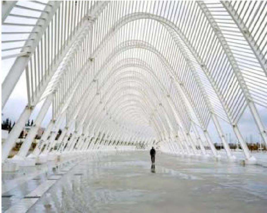
2012, Decadimento di impianti olimpici
