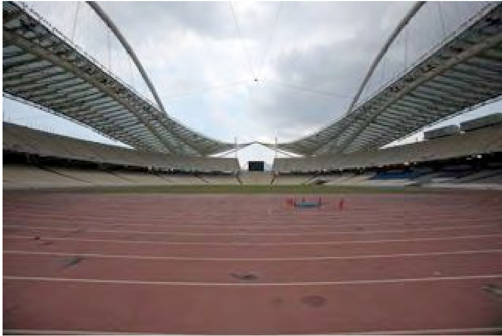
2012, Decadimento di impianti olimpici
