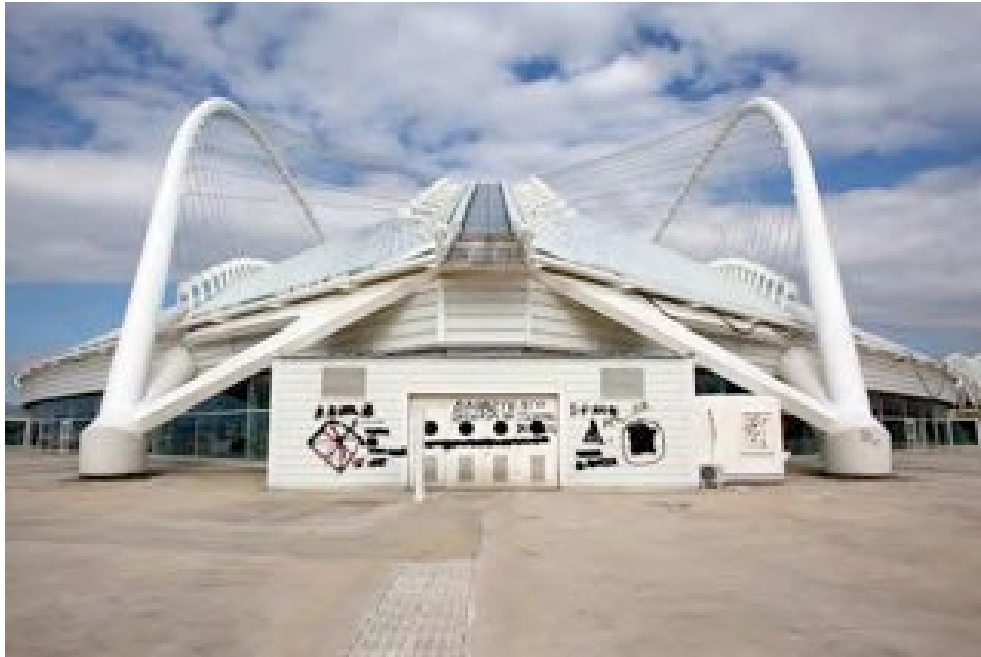
2012, Decadimento di impianti olimpici
