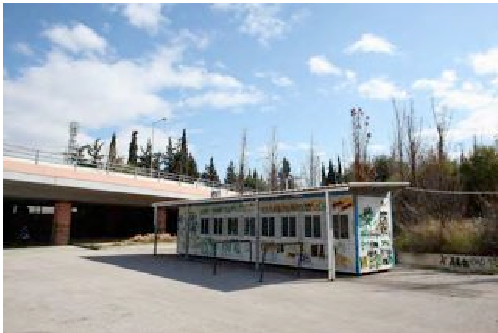
2012, Decadimento di impianti olimpici
