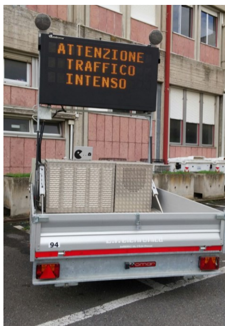
Figura 5.44 Informazione sullo stato del traffico esposta su PMV
