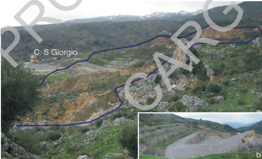
Fig. 58 - Frana in prossimità di C. S. Giorgio a nord-ovest di Geraci Siculo. Il corpo di frana, evidenziato in blu, interessa il fronte di una cava (a) e il piano di coltivazione è tiltato di circa 30° (b).
