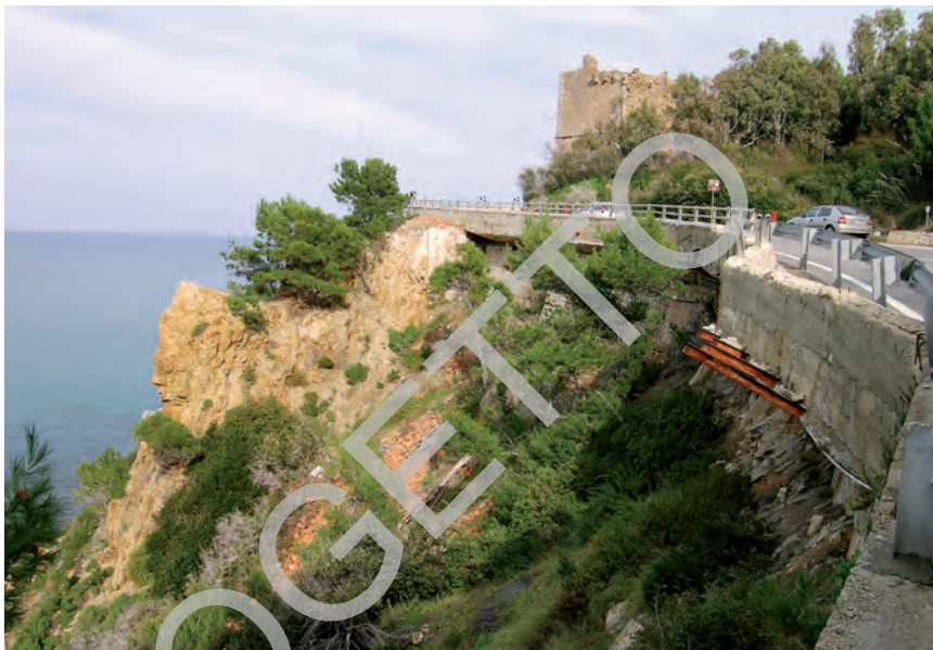
Fig. 59 – Frana attiva nella litofacies argillosa del flysch numidico – membro di Geraci Siculo (FYN 3 ). Loc.: Strada Statale Settentrionale Sicula, km 167, nei pressi di Torre Selichente.
