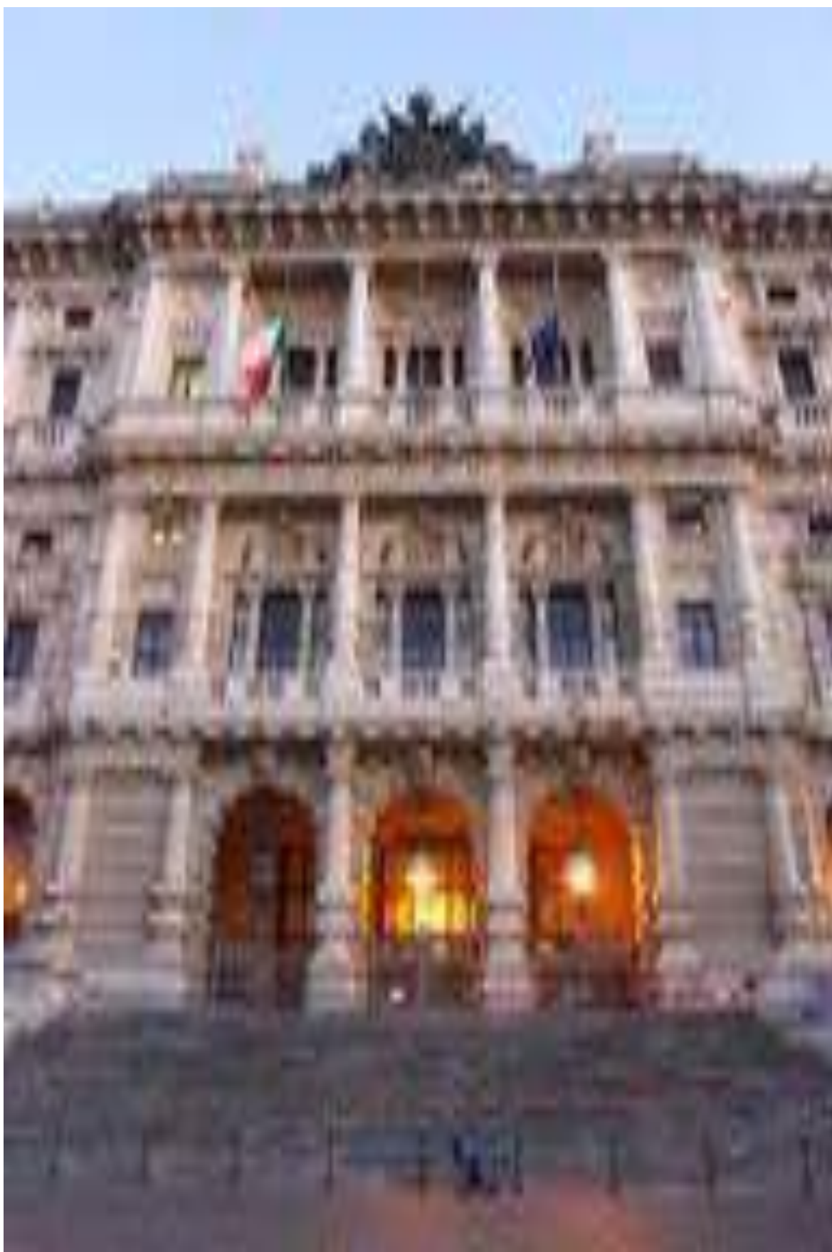
Fig. 48. Palazzo di Giustizia di Roma. Dettaglio della parte centrale della facciata posteriore su piazza Cavour.
