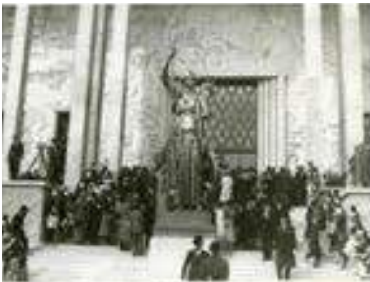
Fig. 391. F. Fichera, Palazzo di Giustizia di Catania, dettaglio dell'ingresso principale.
