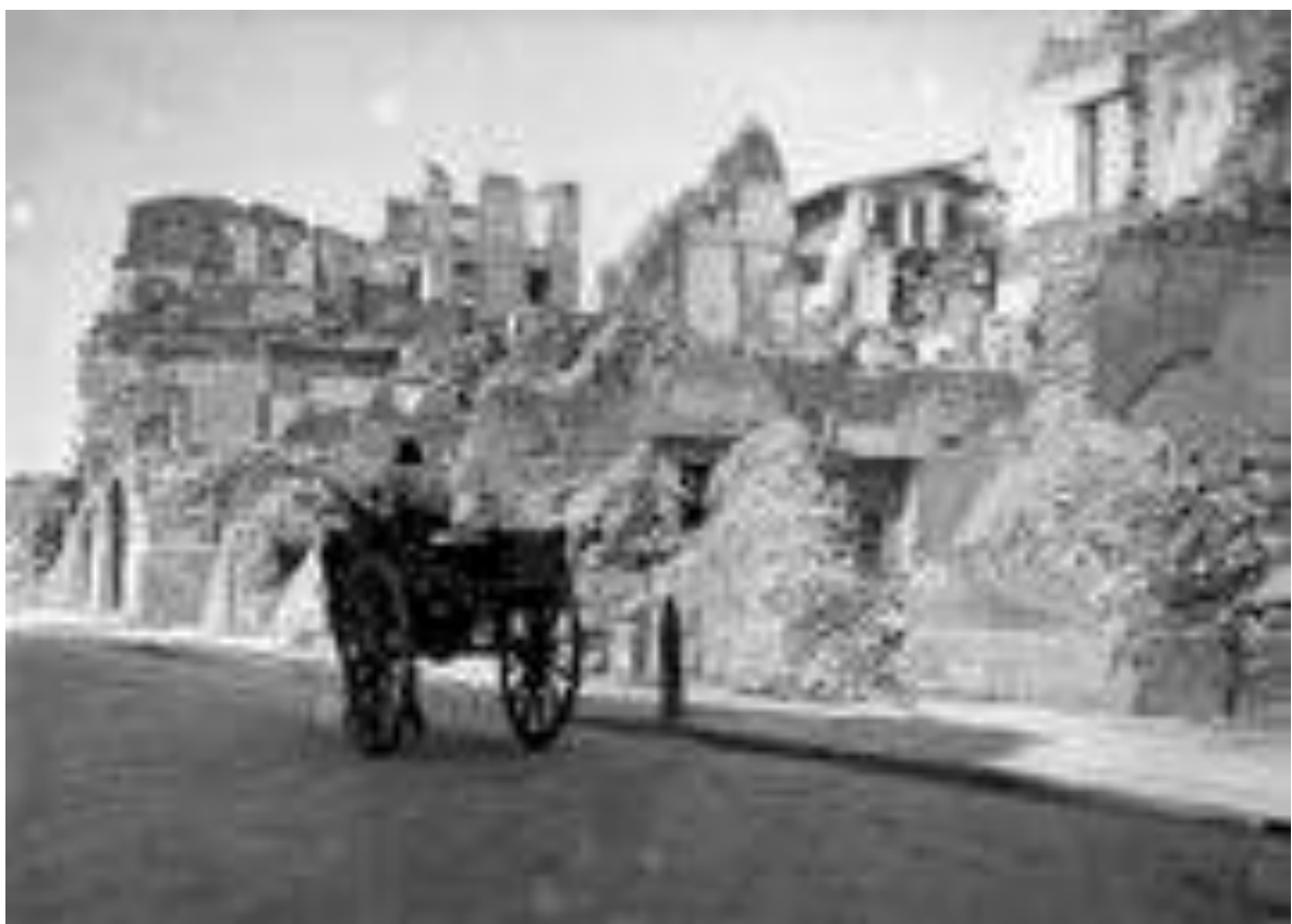
Fig. 116. Messina dopo il terremoto del 1908. www.strettoweb.com e www.iccdold.beniculturali.it .
