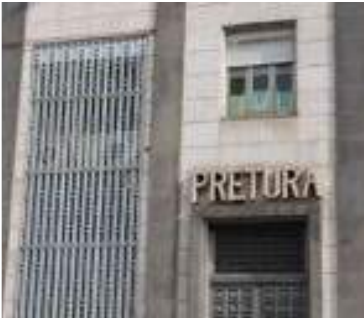
Fig. 383. F. Fichera, Palazzo di Giustizia di Catania, prospetto laterale e dettaglio ingresso Pretura.
