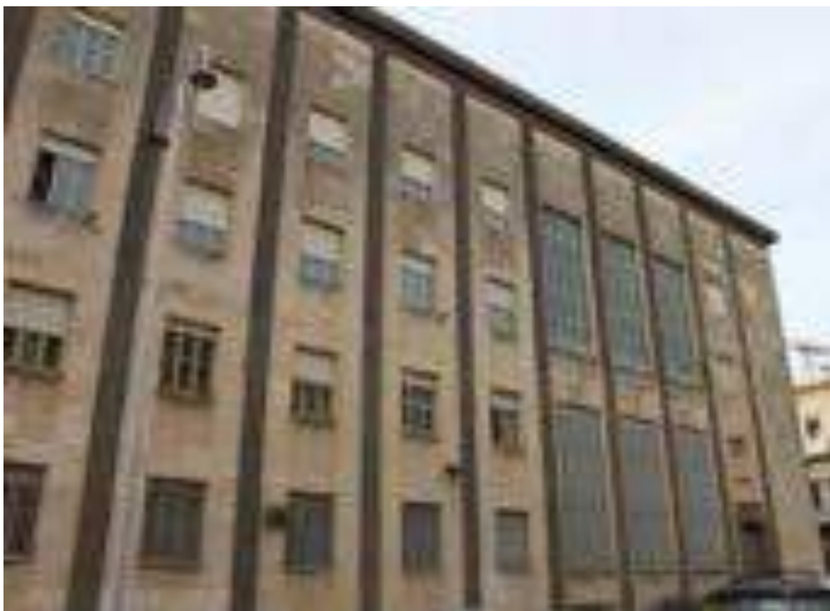
Fig. 384. F. Fichera, Palazzo di Giustizia di Catania, prospetto posteriore e prospetto laterale.
