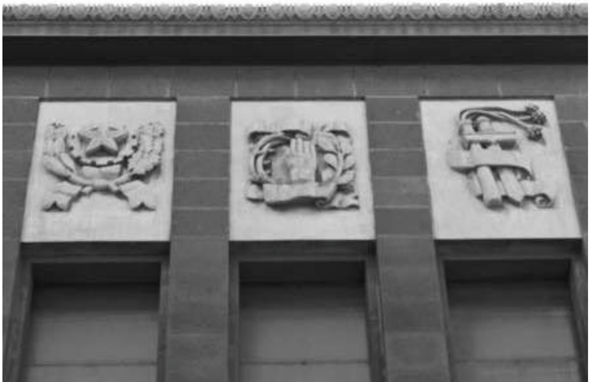
Fig. 385. F. Fichera, Palazzo di Giustizia di Catania, dettagli decorativi nel prospetto posteriore.
