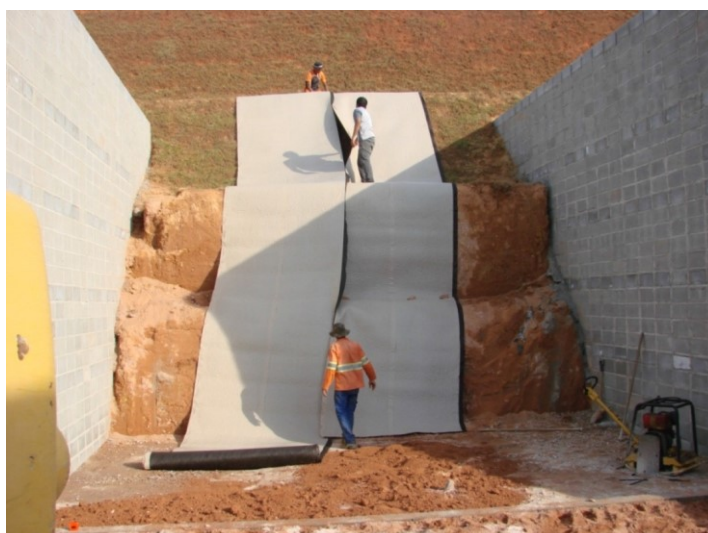
FIG. 2. 29 – Posizionamento dei dreni
