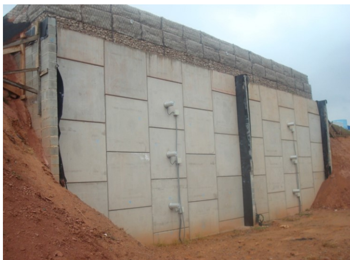
FIG. 2. 35 – Muri completati sottoposti a sovraccarico
