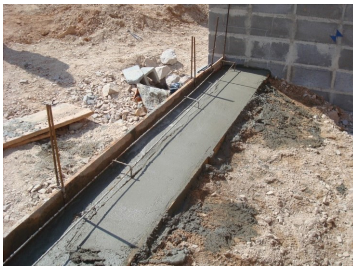
FIG. 2. 28 – Magrone di calcestruzzo alla base
