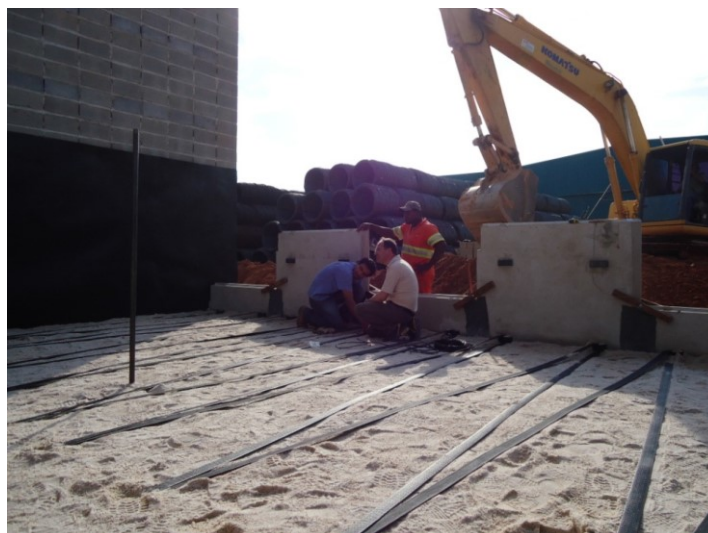
FIG. 2. 32 – Posizionamento geostrip
