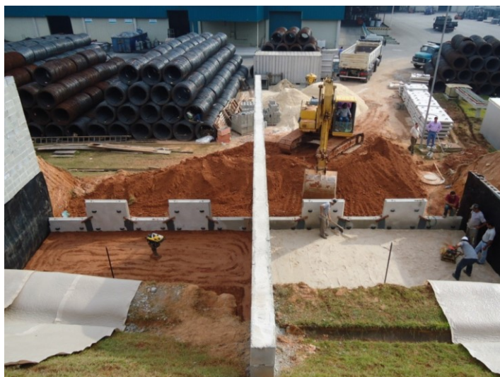
FIG. 2. 30 – Prima fila di pannelli posizionata
