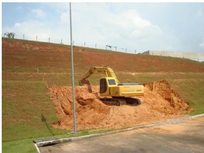
FIG. 2. 26 – Fase di scavo
