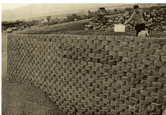
FIG. 1. 52 – Muro non danneggiato in sito 4 (Huang et al., 2003).
