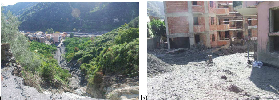
Figura 4.7 Torrente Loco: a) inquadramento della frana, b) edifici interessati dalla colata detritica nel tratto di valle.
