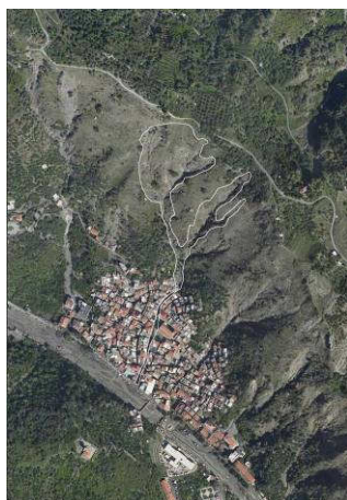
Figura 4.11 Individuazione della frana su Via Chiesa - Torrente Sopra Urno.
