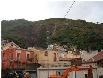
Figura 4.10 Vista frontale della frana generatasi all'interno del bacino Sopra Urno, a ridosso dell'abitato di Giampileri Superiore.
