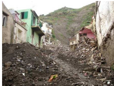
Figura 4.16 Vista del percorso di frana sul bacino del torrente Puntale che si prolunga lungo l'abitato di via Vallone.
