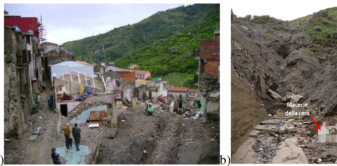
Figura 4.15 Torrente Puntale: colata di fango in via Vallone pochi giorni dopo l'alluvione del 1° ottobre 2009. a) vista dall'alto dei resti delle abitazioni colpite dall'impatto della frana; b) vista lato del versante dei resti delle abitazioni su via Vallone.
