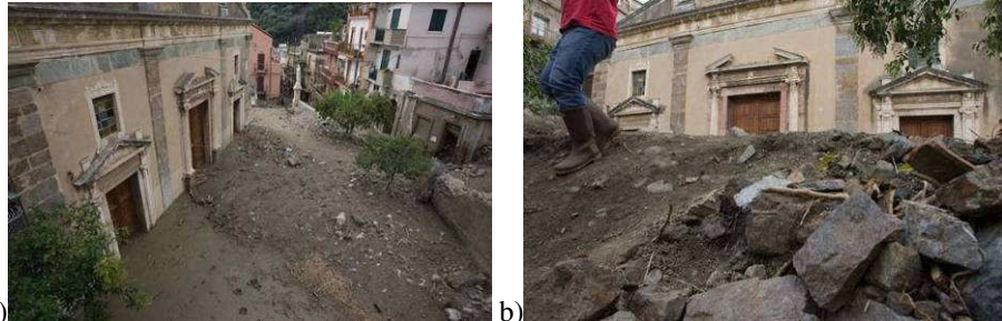
Figura 4.13 Torrente Sopra Urno: a) colata di fango che ha interessato la via Chiesa; b) piazza di fronte alla chiesa invasa dal fango.
