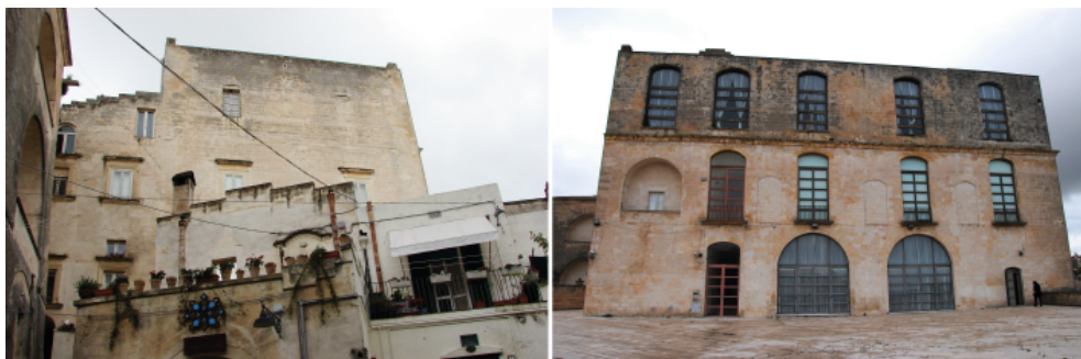
Figura 4.5 – Angolo sud-ovest, a destra fronte sud.
