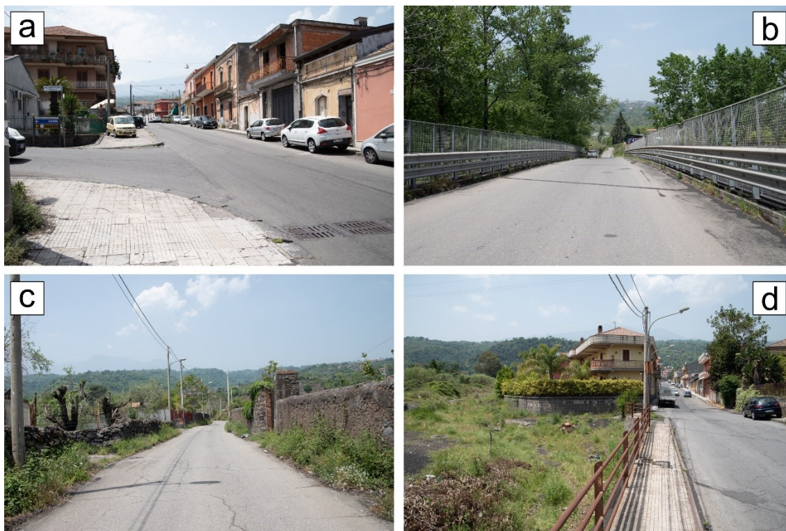
Fig. 8.19 – Situazioni di rischio idraulico nella frazione di Macchia di Giarre: a) Incrocio tra la via Principe di Piemonte e via Carlo Parisi; b) Viadotto in via Firenze; c) via Zinghirino; d) Fine di via Risorgimento e inizio di via della Regione. (Ubicazione foto in Fig. 8.21).
