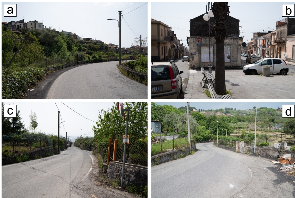
Fig. 8.20 – Situazioni di rischio idraulico nella frazione di San Giovanni Montebello: a) Via dei Paoli; b) Bivio tra via Roma (a destra) e via Amedeo di Savoia (a sinistra) nei pressi della piazza S. Giovanni battista; c) Via Cimitero al confine comunale con Sant’Alfio; d) Via Giacinto Carini. (Ubicazione foto in Fig. 8.21).
