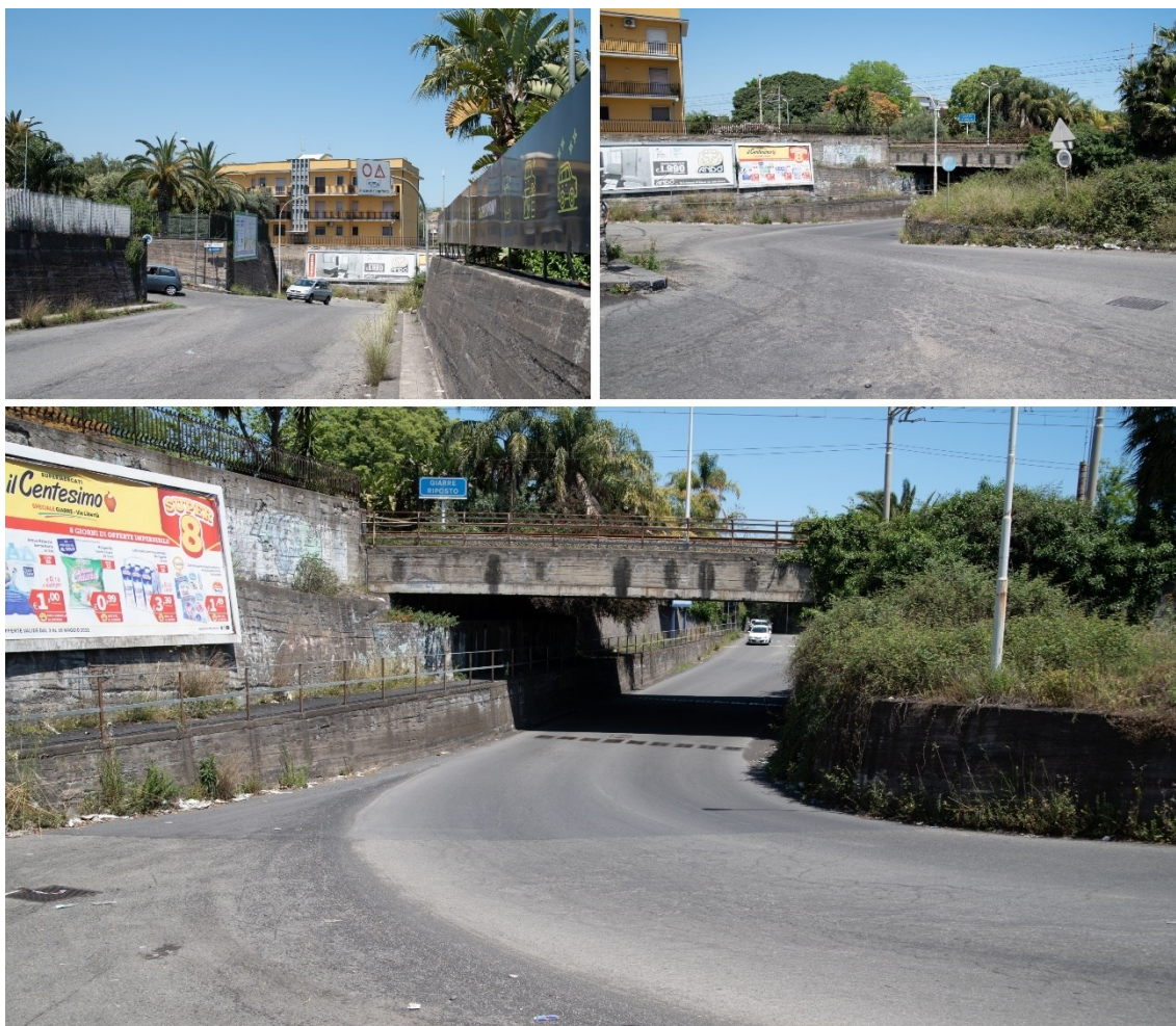
Fig. 8.7 – Zona a rischio lungo via Martiri di via Fani (ubicazione foto in Fig. 8.9).
