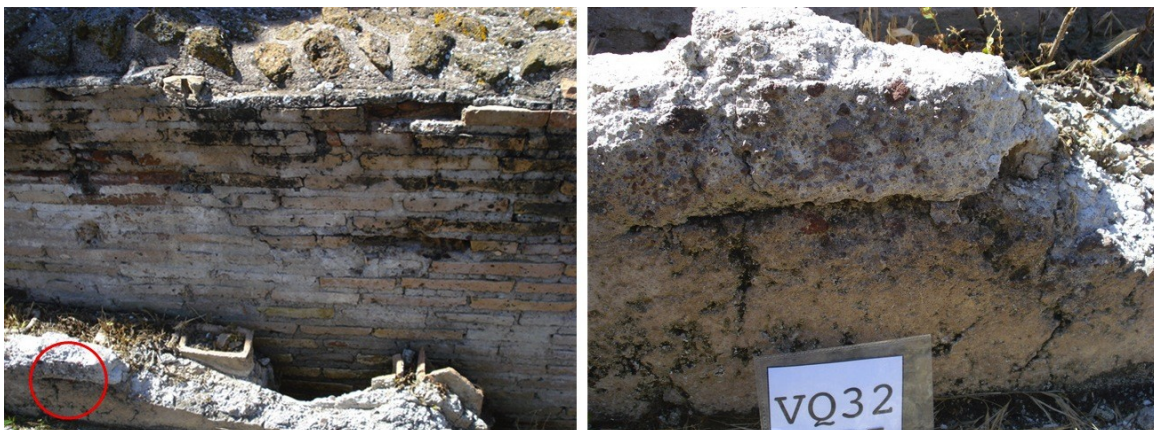
Figura 28. A sinistra foto del paramento murario dal quale è stato prelevato il campione VQ32 e particolare (a destra) dell'area di prelievo.
