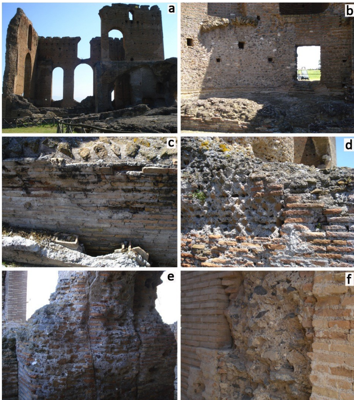
Figura 8. Foto mostranti le diverse tecniche edilizie presenti nella villa (a, b, c, d) ed evidenze delle diverse fasi costruttive (e, f).
