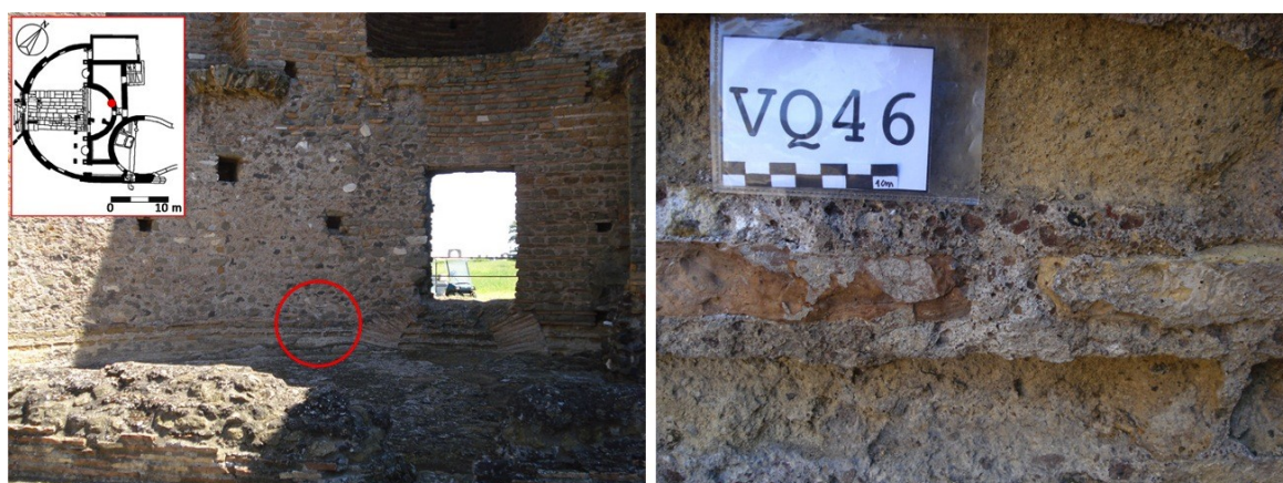
Figura 25. A sinistra foto generale del paramento murario dal quale è stato prelevato il campione VQ46 (foto a destra).
