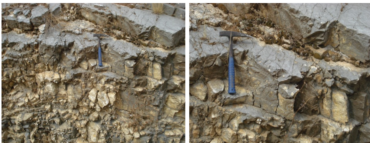
Figura 40. Foto generale (a sinistra) e particolare (a destra) del calcare Maiolica.
