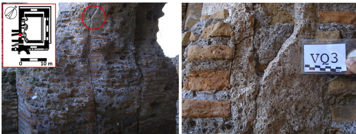
Figura 26. Foto del paramento murario d'ingresso del Calidarium (a sinistra) e particolare (a destra) dell'area da cui è stato prelevato il campione VQ3.
