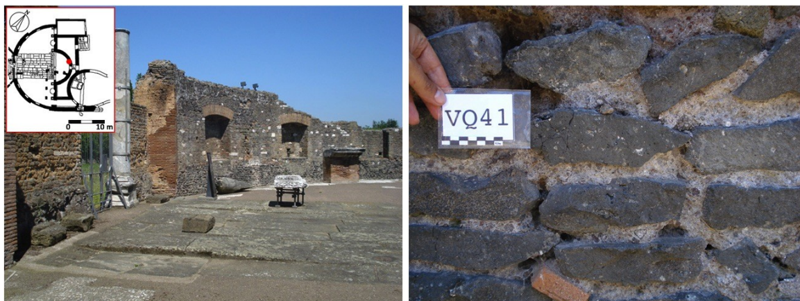
Figura 22. A sinistra foto del cortile interno del Ninfeo ; a destra area dei prelievo del campione VQ41.
