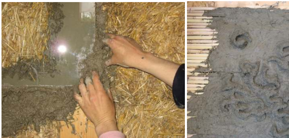
Figg. Il cantiere scuola della Casa di ToTi: realizzazione di inserti artistici. Foto dell'autore
