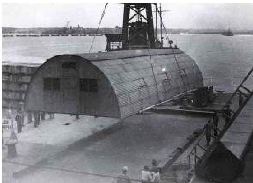
Fig. 20, la "Quonset hut" prodotta durante la seconda guerra mondiale
