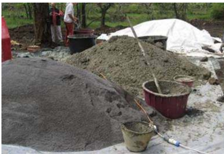
Fig. 68 Terra d'argilla e azolo impiegati nell'impasto per il confezionamento dei blocchi.
