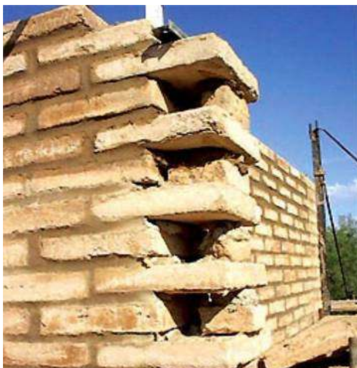
Fig. 62, Muro in mattoni Adobe a giunti sfalsati.
