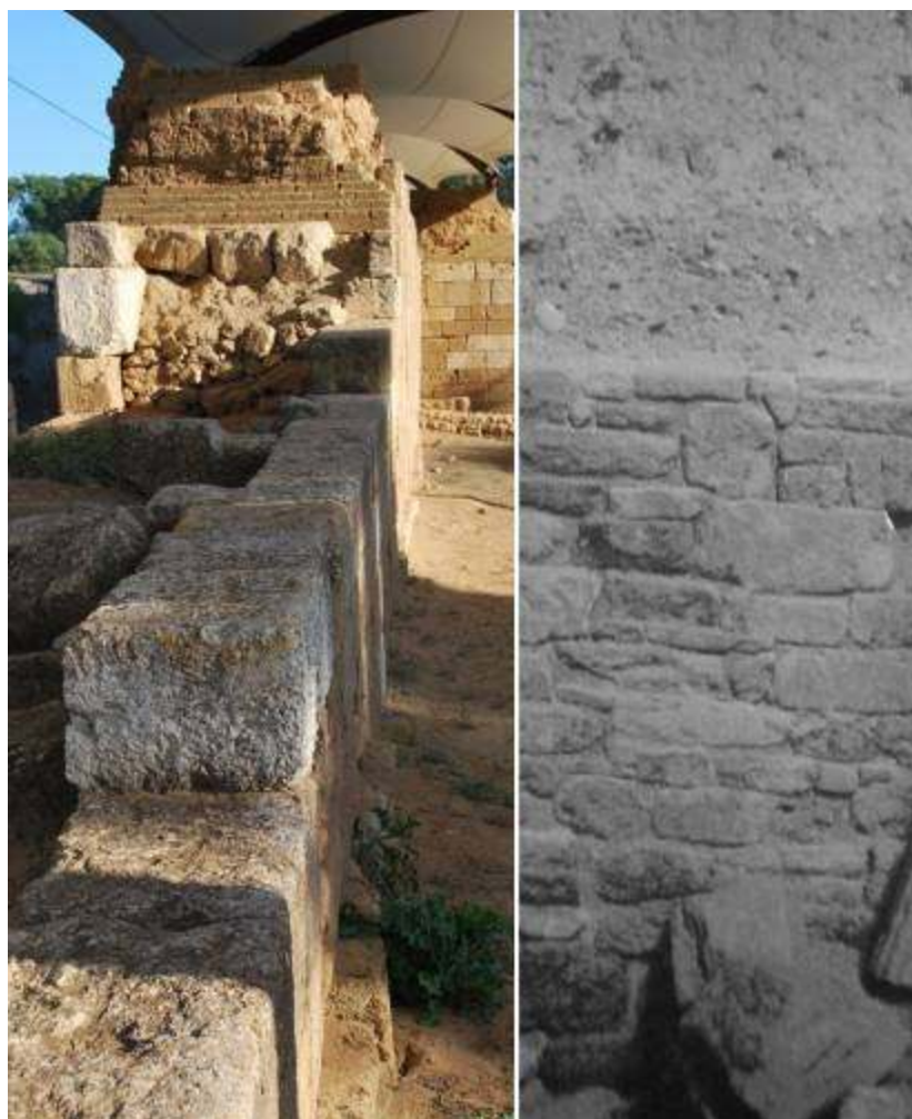
Fig. 34, Mura Timoleontinee, III sec. A.C., Capo Soprano, Gela (I); Muro contro terra di una casa d'abitazione, basamento in pietra e sovrastruttura in terra battuta, quartiere ellenistico romano di Eraclea Minoa, Agrigento, (I)
