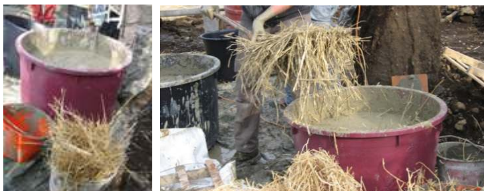
Figg. Il cantiere scuola della Casa di ToTi: preparazione delle miscele per gli intonaci, la paglia. Foto di Elisabetta Campisi
