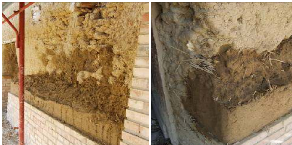
Figg. Il cantiere della “casa di Teresa” del Comune di Casalıncontrada: il muro in fase di ripristino: Foto dell'autore
