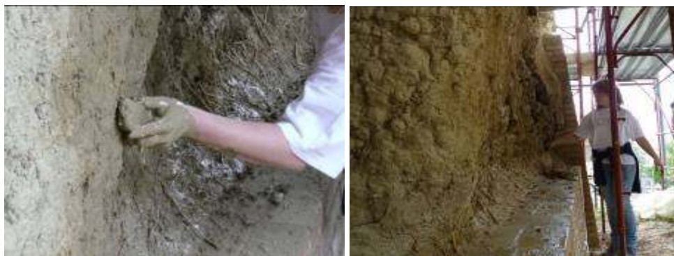
Figg. Il cantiere della "casa di Teresa" del Comune di Casalincontrada: preparazione del fondo del muro esistente con la barbottina in terra cruda. Foto dell'autore e di Elena Bignamini
