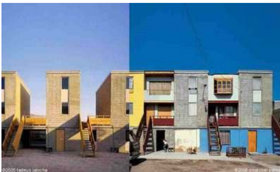
Fig. 6, Project Elemental-Alejandro Aravena, prima e dopo l'intervento degli assegnatari
