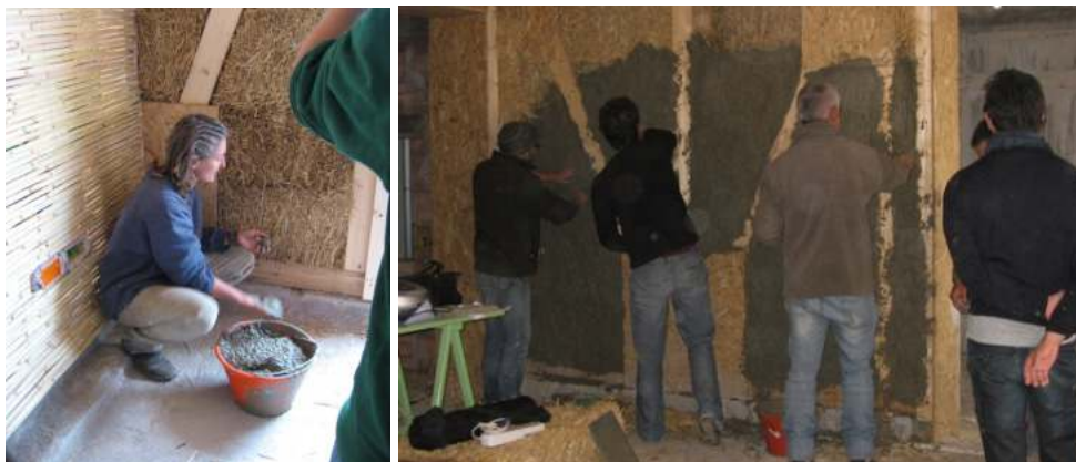
Figg. Il cantiere scuola della Casa di ToTi: preparazione delle superfici da trattare. Foto di Elisabetta Campisi
