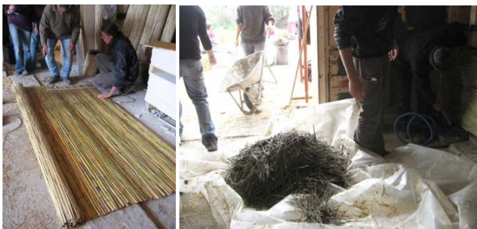
Figg. Il cantiere scuola della Casa di ToTi: realizzazione delle pareti in terra paglia, taglio delle stuoie di incannucciato e mescola della paglia con biacca d'argilla. Foto di Elisabetta Campisi
