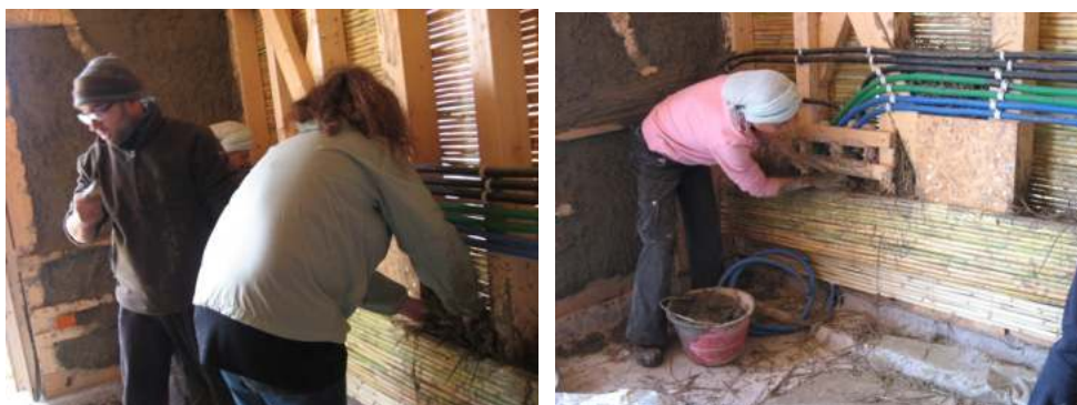
Figg. Il cantiere scuola della Casa di ToTi: realizzazione delle pareti in terra paglia, posa in opera della terra paglia. Foto di Elisabetta Campisi
