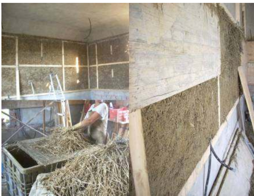
Fig. 52, costruzione di partizioni verticali in terra paglia
