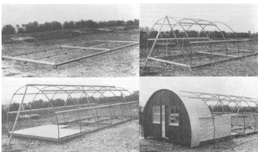
Fig. 19, la "Nissen hut", fasi di montaggio
