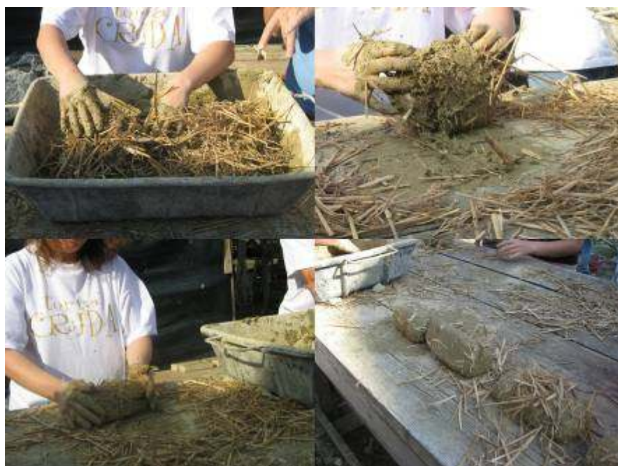
Fig. 50, preparazione dei massoni, Workshop "realizzare con la terra" Casalincontrada, Chieti, 2010
