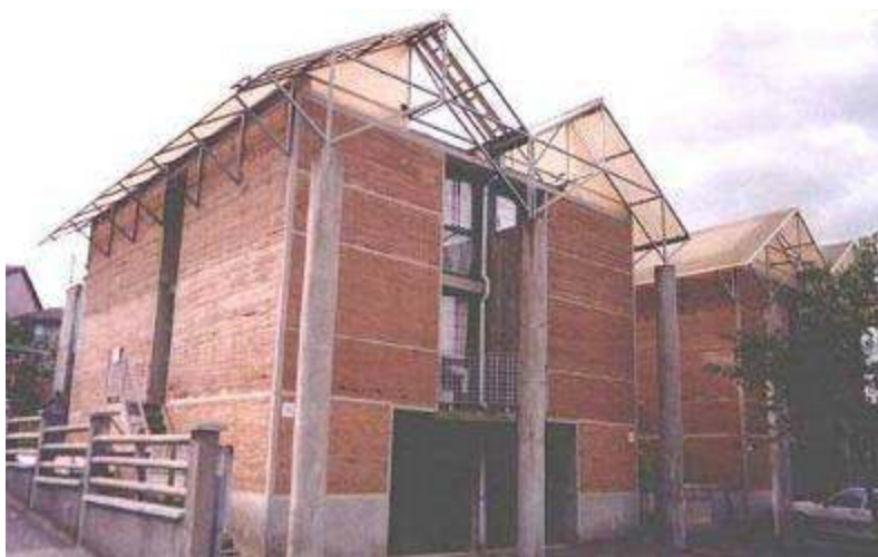
Fig. 38, Case d'abitazione, La Domaine de la Terre a Ville Fontaine, Francia
