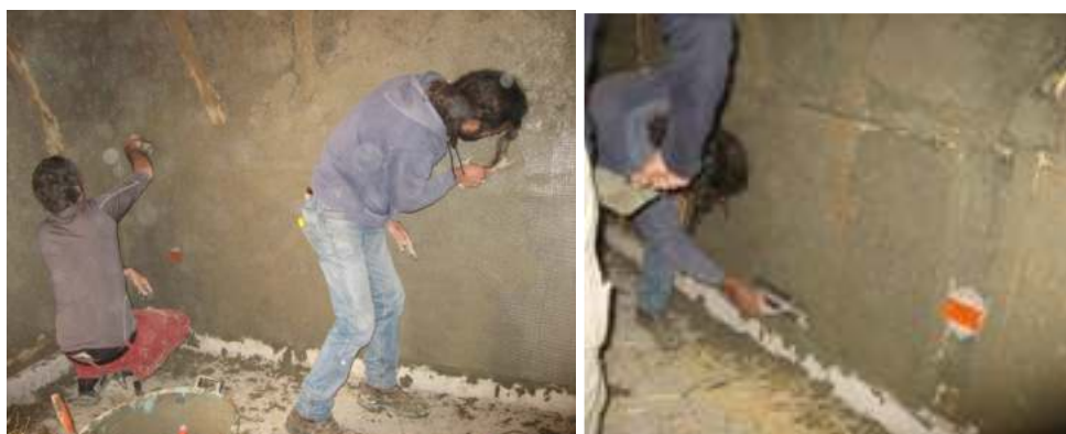
Figg. Il cantiere scuola della Casa di ToTi: posa in opera dell'intonaco sulle pareti che presentano disomogeneità dei materiali, impiego di reti porta intonaco. Foto dell'autore
