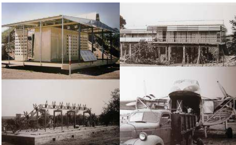
Fig. 13, La "maison tropicale" di Jean Prouvé, Ateliers Jean Prouvé, Maxeville, France Porzione dell'edificio montato a Maxeville, 1949, montaggio a Niamey, Niger, 1949, Costruzione a Brazzaville, parti dell'edificio vengono scaricate da un aereo cargo.
