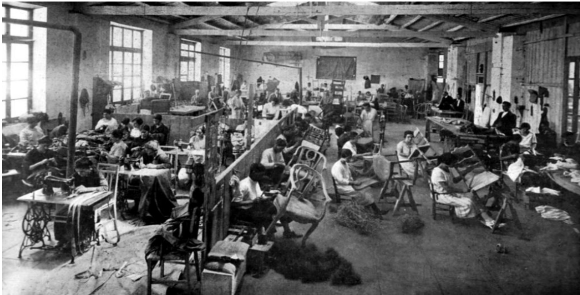
Figure: 56 - Fabbrica Ducrot, lavoratrici, anni '50; 57 - lavoratori anni '60; 58 - i cantieri oggi 134 .
