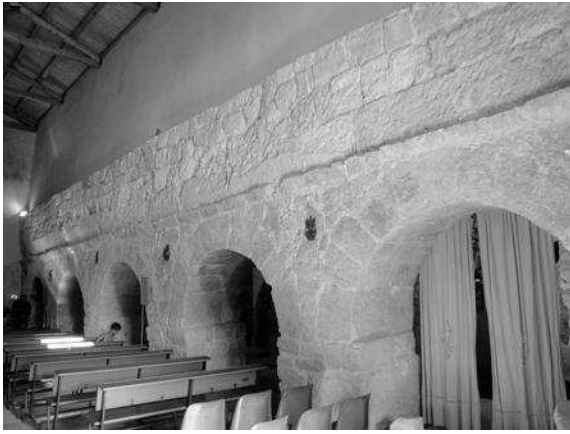
Fig. 7. San Foca, interno. I pilastri che separano la navata centrale e destra.
