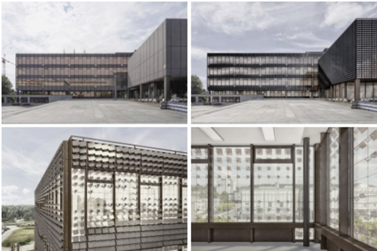
Fig. 2.19. ASF – Adaptive Solar Façade. Fotomontaggio per simulazione di un intervento di retrofit sull'edificio HIL dell'ETH di Zurigo. In alto a sinistra: fotografia dell'edificio. In alto a destra: fotomontaggio dell'edificio con l'ASF. In basso a sinistra: vista ravvicinata. In basso a destra: vista dall'interno (Nagy et al., 2016)
