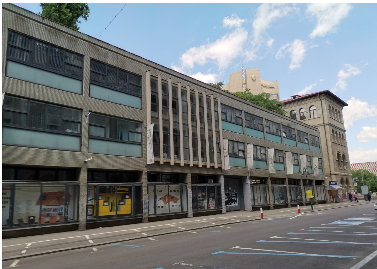
Fig. 4.30. Università di Architettura e Urbanistica UAUIM "Ion Mincu" di Bucarest, prospetto su Strada Edgar Quinet
