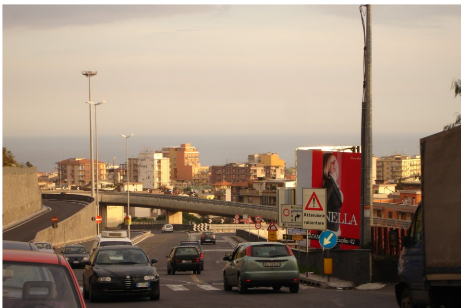
Fig. 3.13 – Arteria stradale tra i confini amministrativi di Catania e Gravina
