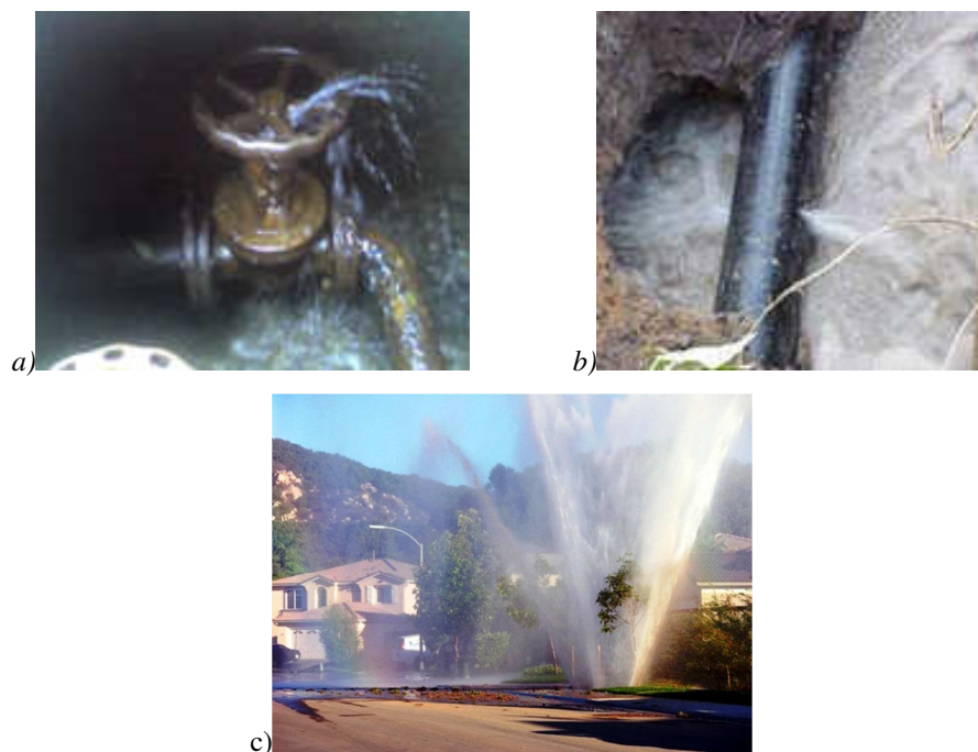
Figura 2.1: Immagini di tre tipologie di perdite a) perdite di sottofondo b) perdite da rotture non segnalate c) perdite da rotture segnalate
