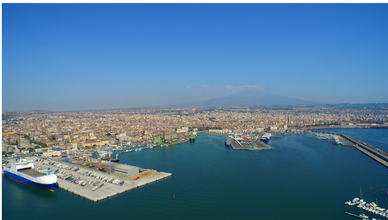
Figura 120 - L'area portuale con la Nuova Darsena Commerciale realizzata a sud (Fonte: AP CT)
