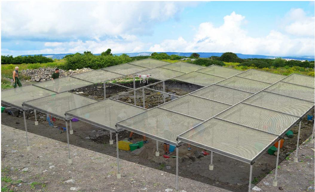
Fig. 4.20 | Fotoinserimento del sistema modulare di copertura sugli scavi archeologici dell'Insula di Akrai
