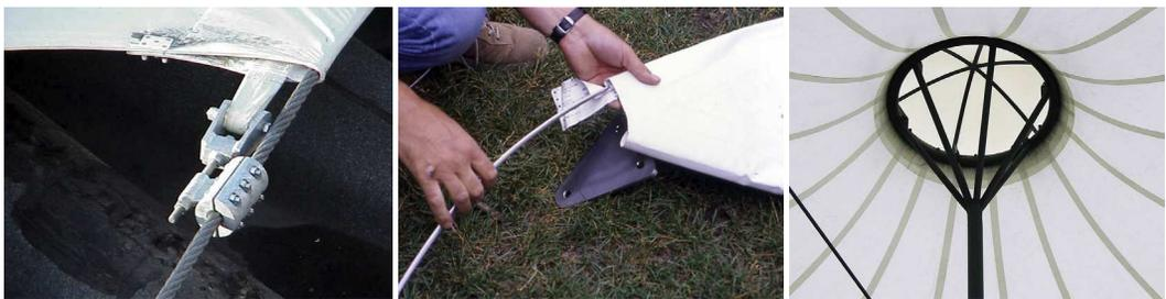
Fig. 4.11 | Dettagli di alcuni sistemi di connessione e di giuntura utilizzati per le *textile architecture*.
