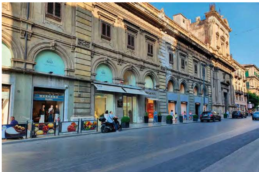
Fig. 1 – Via Ruggero Settimo – L'ex Conservatorio di S. Lucia. Al piano terra alcuni moderni esercizi commerciali
