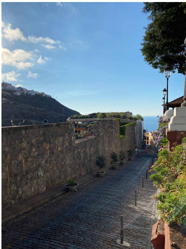
Fig. 9 – Il nuovo muro di pietra che separa il parco dalla città (foto: Simona Calvagna).
