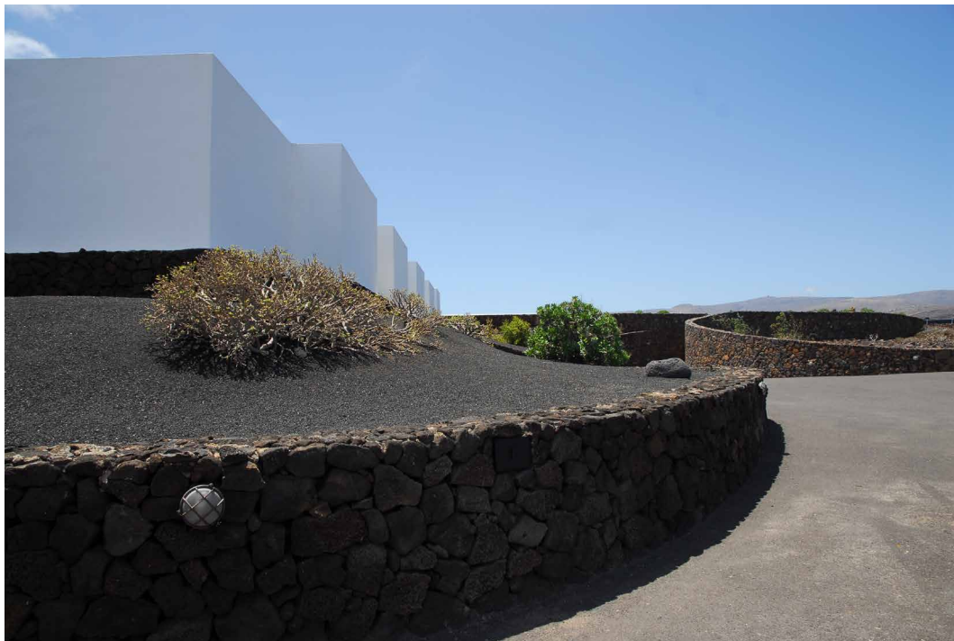
Fig. 1 – C. Manrique, Los Jameos del Agua , 1963-1977, Lanzarote. Scorcio dei volumi esterni costruiti attorno al tunnel lavico (foto: Simona Calvagna).
