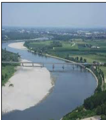
Figura 4.6 - Alveo sinuoso: Fiume Po (AA.VV, 2009).
