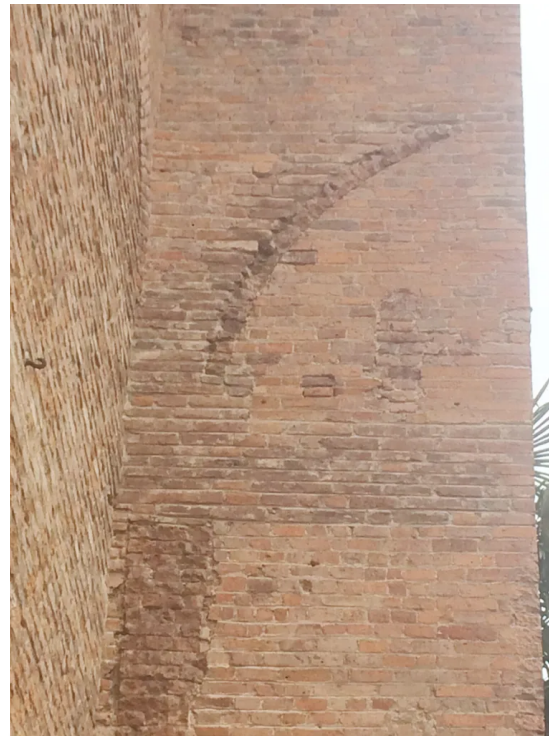
Dettaglio della traccia arcuata presso il lato interno del contrafforte centrale del transetto
