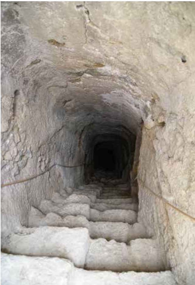
Fig. 7 - All'interno della discenderia: Si notino i gradini sfalsati ("scaluni ruttu", cioè scala rotta), costruiti appositamente per agevolare la faticosa risalita dei minatori. Solfara Persico. Parco Minerario Gabbara (San Cataldo, CL)
