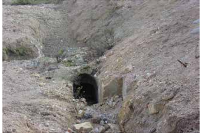
Fig. 12 - Discenderia parzialmente interrata
