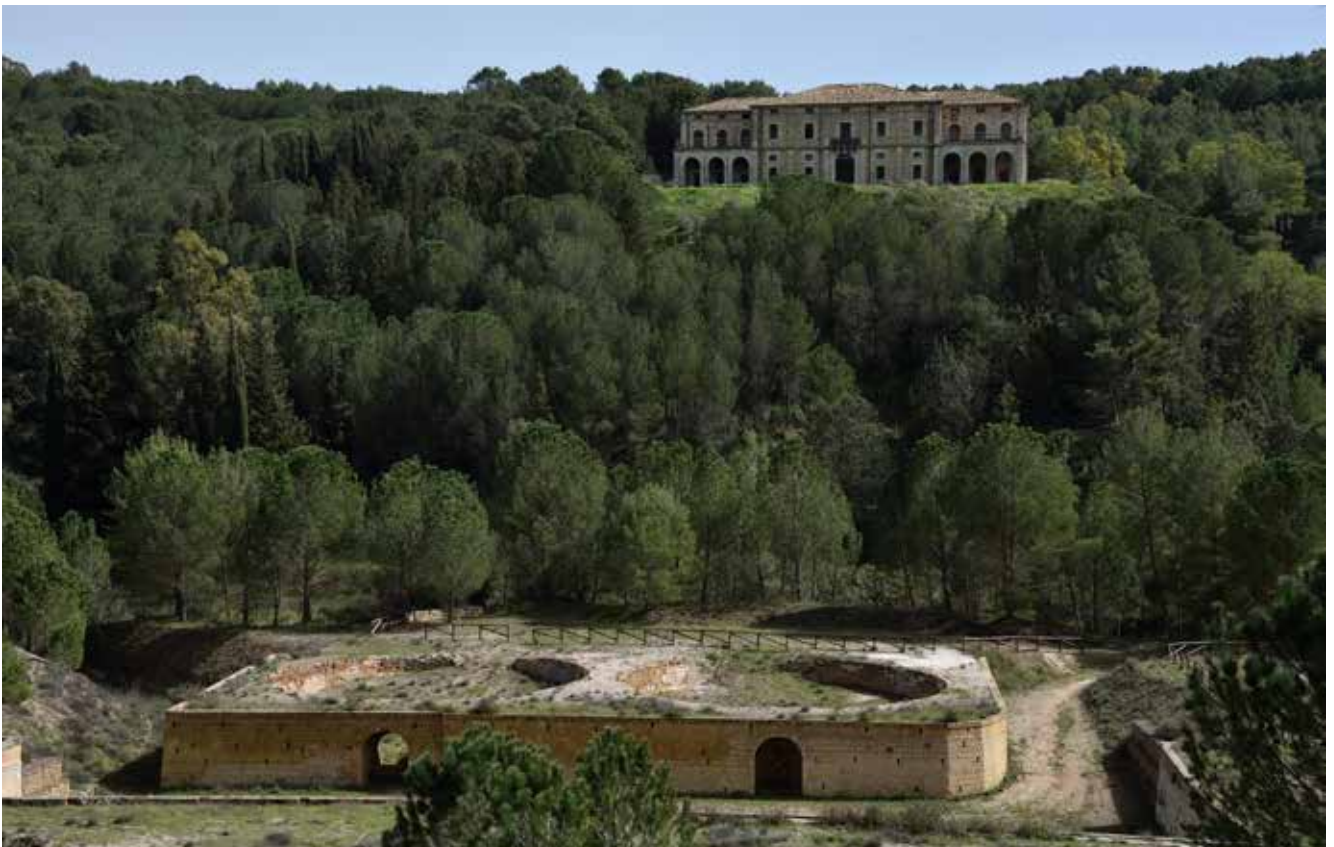
Fig. 5 - Impianto dei due calcheroni; sullo sfondo il Palazzo Pennisi
