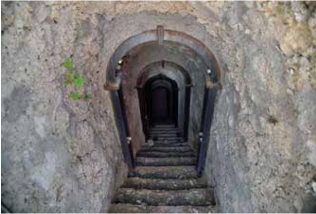
Fig. 11 - Ingresso di una discenderia ristrutturata
