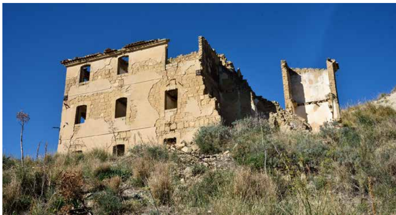
Fig. 2 - Resti degli edifici amministrativi presso la miniera Bambinello (EN)
