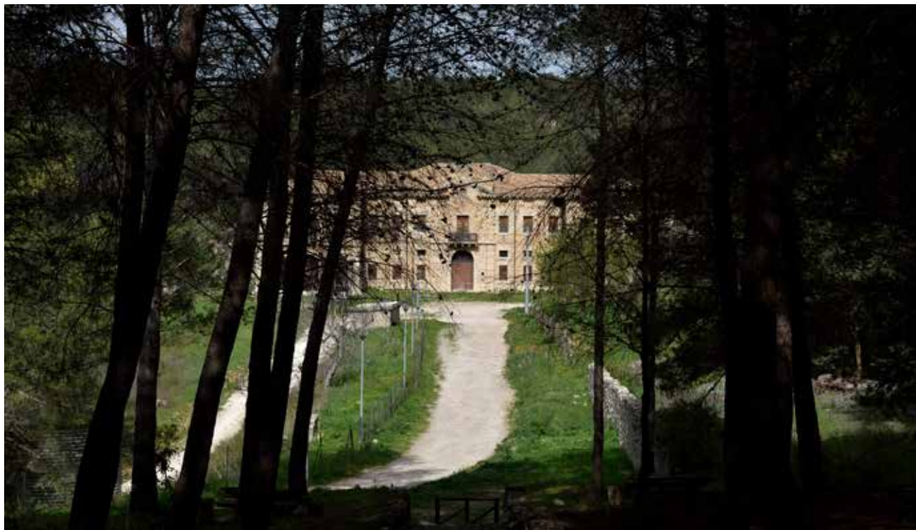
Fig. 2 - Palazzo Pennisi, visto dalla Via del Mosto
