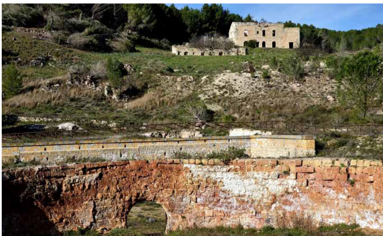
Fig. 10 - Interno dei calcheroni, con sullo sfondo il Dopolavoro e gli alloggi degli operai
