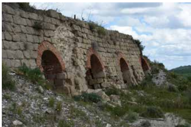
Fig. 10 - Miniera Zimbalio (EN). Complesso dei forni Gill (a sinistra) e particolare del foro della "Morte" (a destra)
