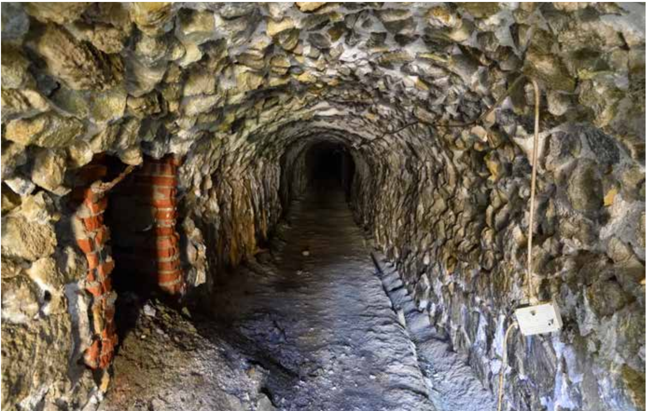
Fig. 17 - Tratto di una galleria ricostruito in pietra. Miniera Cozzo Disi (AG)
