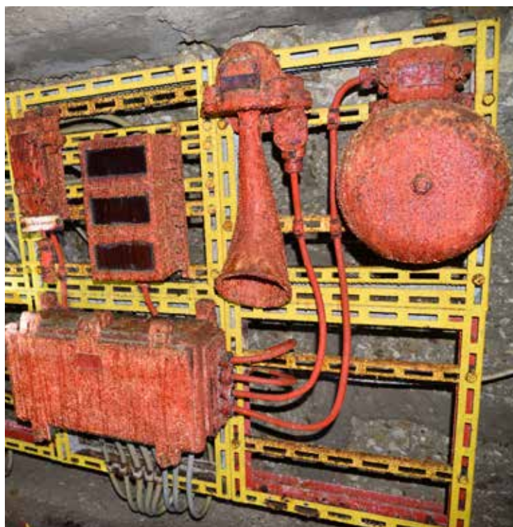
Fig. 20 - Resti delle attrezzature del personale di sorveglianza. Miniera Cozzo Disi (AG)
