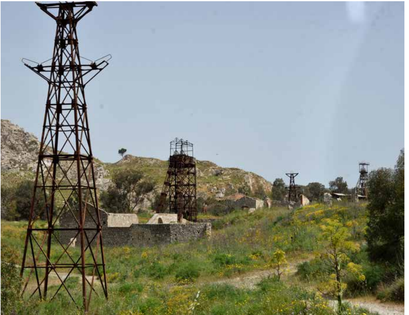
Fig. 10 - Ruedi e tralicci della teleferica utilizzata per il trasporto del materiale. Complesso Minerario Trabia-Tallarita (Riesi, CL)
