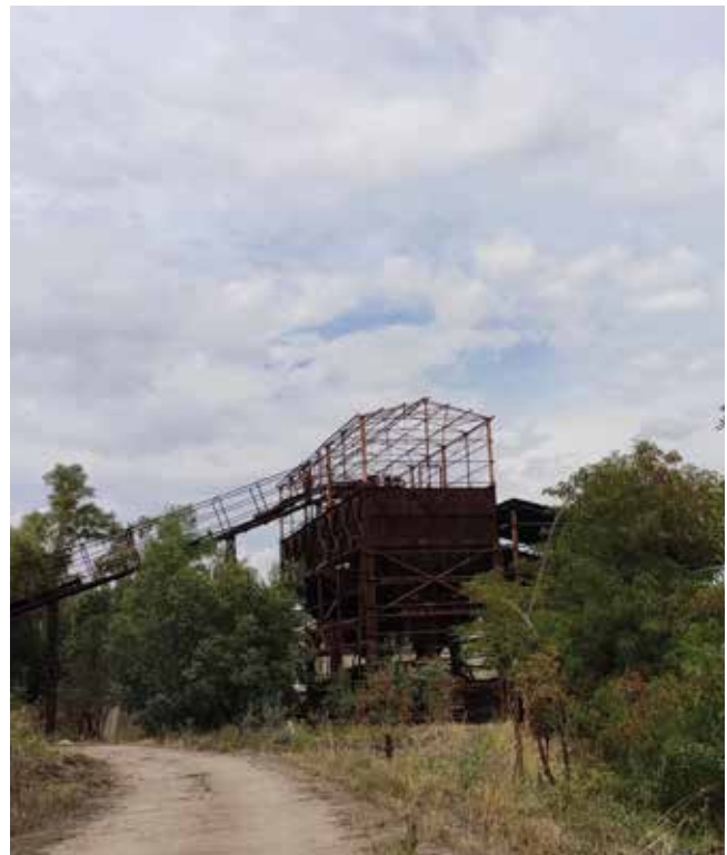
Fig .7 - Miniera Trabonella: Foto attuale dello scheletro del nastro trasportatore e della struttura di raccoglimento del materiale estratto
