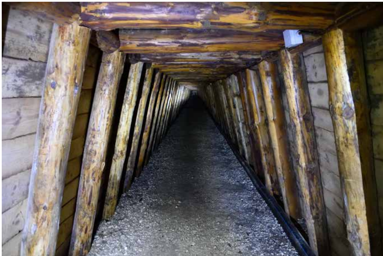
Fig. 18 - Tratto accessibile della galleria ricostruito con camicia in legno. Miniera Cozzo Disi (AG)
