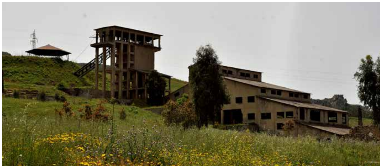
Fig. 11 - Impianto di estrazione dello zolfo dalla matrice tramite flottazione. Complesso Minerario Trabia-Tallarita (Riesi, CL)
