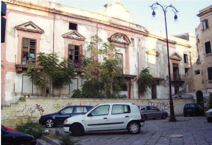
Foto, edificio abbandonato via S. Nicolò all'Albergheria, Quartiere Ballarò
