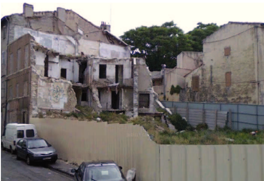
Foto, abitazione crollata in rue Guichard, Quartier de Saint Mauront
