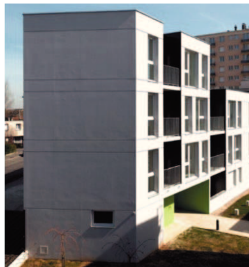
Logements sociaux et ateliers d'artistes à Montreuil (93) Maîtrise d'œuvre : Taktik architectures, Jean-Julien Simonot,
