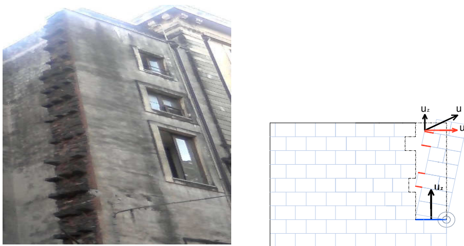
Figura 5.21 - a) Esempio di parete semi ammorsata; b) Valutazione resistenze attrittive
