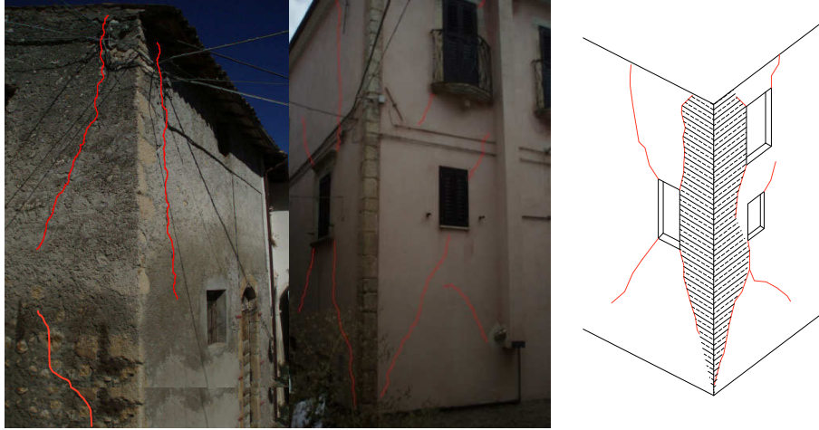
Figura 5.19 - b) Ribaltamento dell'angolata con trascinamento di porzioni a doppio cuneo
