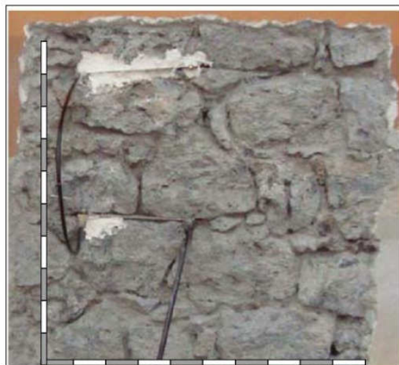
Ingranamento nel piano del paramento L.M.T=1,48 - P.R. Orizzontalità dei filari - R.
