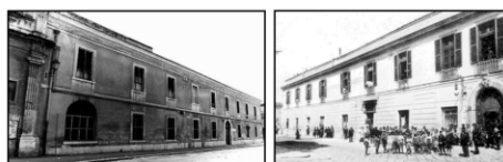
Fig. 2-3: Ingresso principale Via Arpi 155, via Novescento (data incerta)
