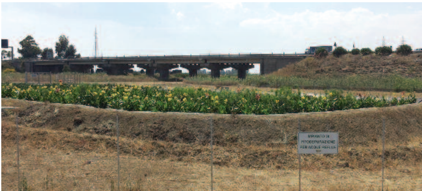
Fig. 10 - Stato di fatto del sistema di fitodepurazione a servizio dell'IKEA Store di Catania.
