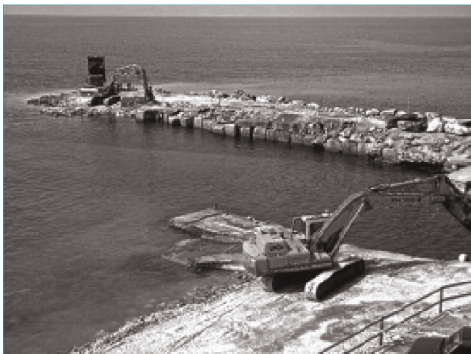
I lavori al porto.
