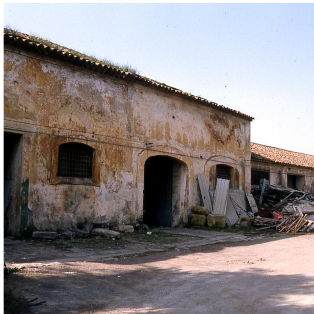
Fig. 4 - Corpo di fabbrica meridionale adibito a magazzini prima della ristrutturazione (1991).
