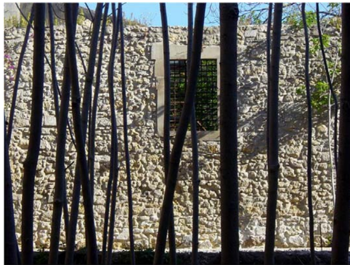
Il giardino di Artemide: setto murario appartenente agli edifici demoliti
