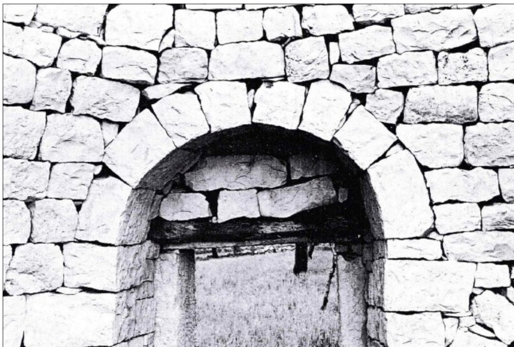
FIGURA 2 Un esempio di costruzione dell'architrave di un trullo
