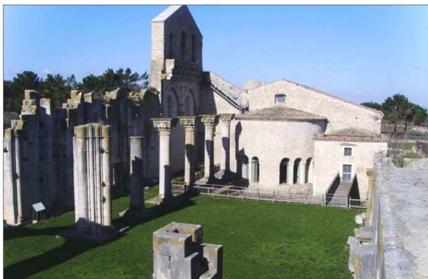
Fig. 4. Deambulatorio della chiesa vecchia visto dall'interno dell'Incompiuta: in fondo a sinistra, il campanile (foto Sileno).
