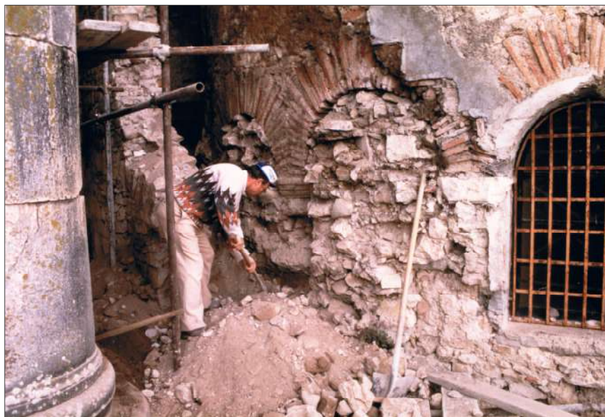
Fig. 7. Lavori di ripristino dell'area esterna presso il deambulatorio, 1988 (foto Sileno).
