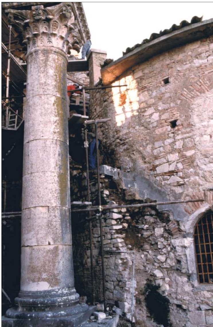
Fig. 9. Gradinata di accesso al campanile durante la demolizione, 1988 (foto Sileno).
