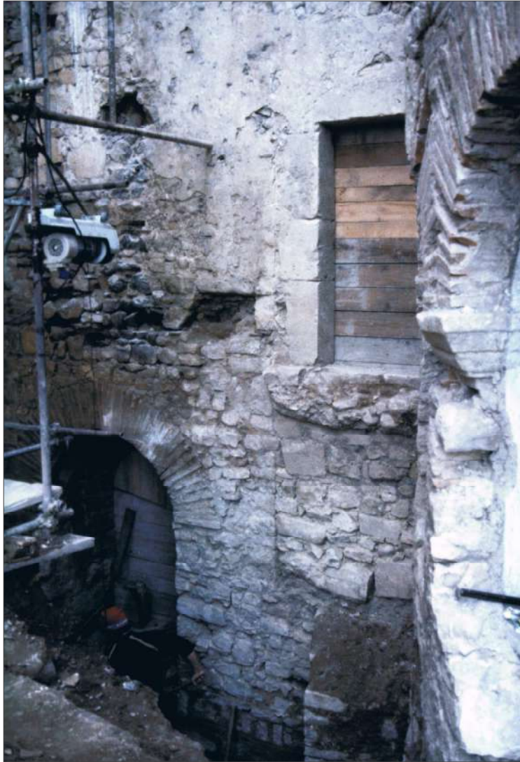
Fig. 12. Gradinata di accesso al campanile al termine della demolizione, 1988. A sinistra è visibile la porta di età paleocristiana (foto Sileno).
