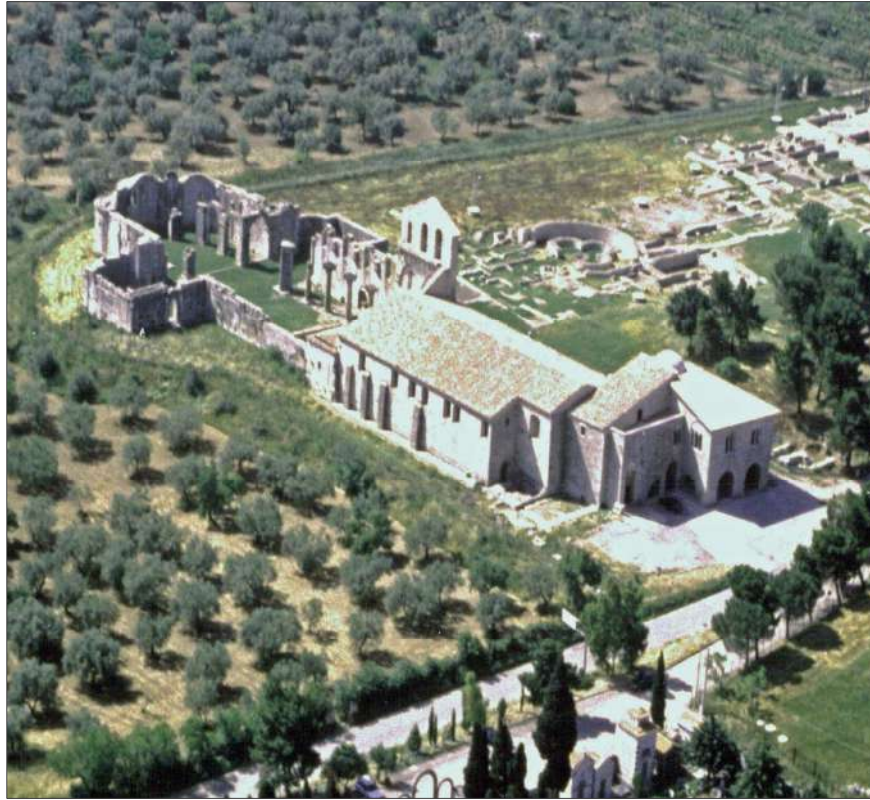
Fig. 1. Foto aerea del complesso della Trinità.
