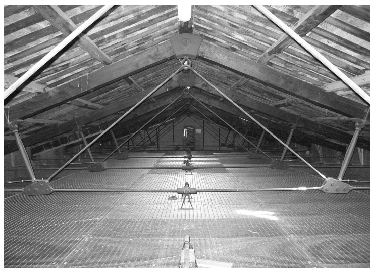
Fig. 2. Le capriate Polonceau della copertura dell'aula Giulio Cesare (foto degli autori).
