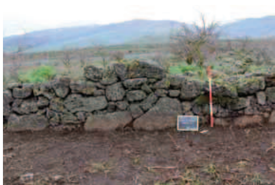
2. Muro di recinzione, particolare
