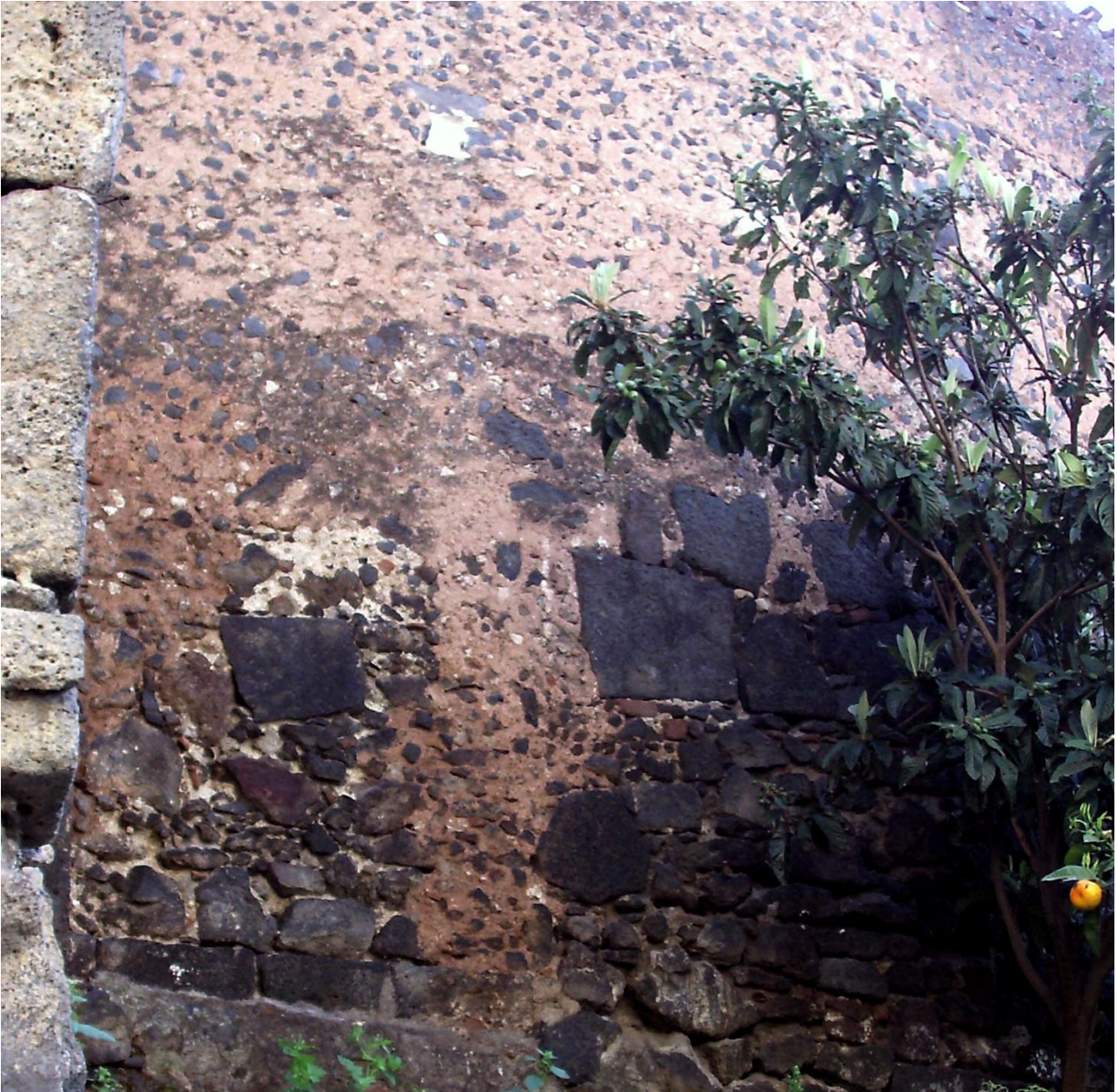
Fig. 3 - Catania, Antico Corso. Blocchi poligonali reimpiegati nella cortina muraria e alla base delle mura tardo medievali.
