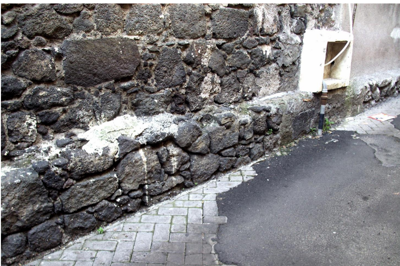
Fig. 12 - Lo zoccolo alla base del muro del reclusorio delle Verginelle, da sud. Dettaglio della tecnica pseudo-polygonale a piccoli blocchi.
