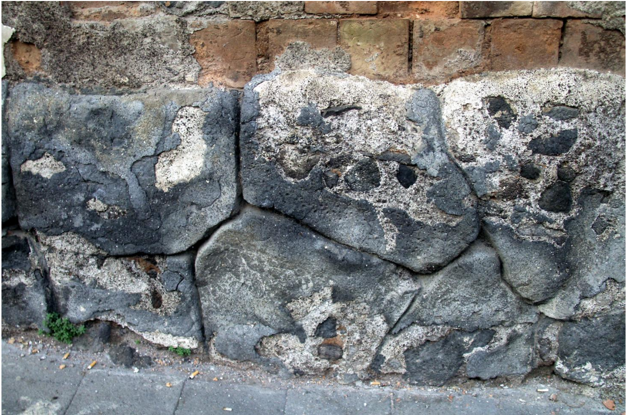
Fig. 7 - Dettaglio della struttura poligonale del muro di Via Santa Maddalena.
