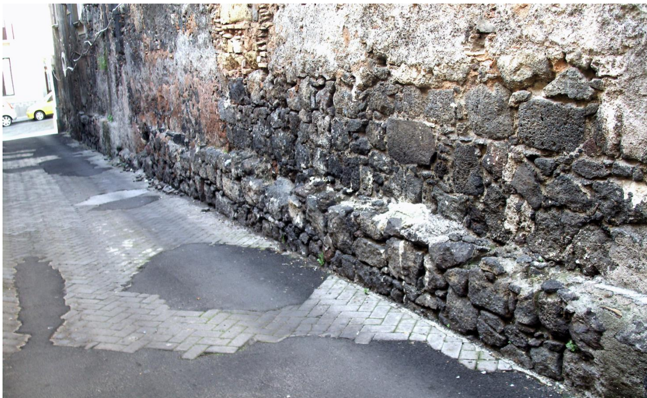
Fig. 11 - Lo zoccolo alla base del muro del reclusorio delle Verginelle, da nord.
