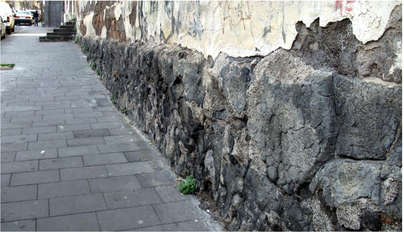
Fig. 5 - Il “muro poligonale” di via Santa Maddalena, da nord.
