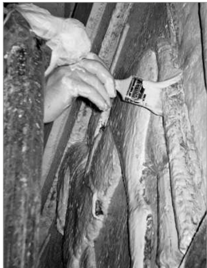
Fig. 22. Il separatore messo in opera a pennello (foto Arch. S. Rizza).
