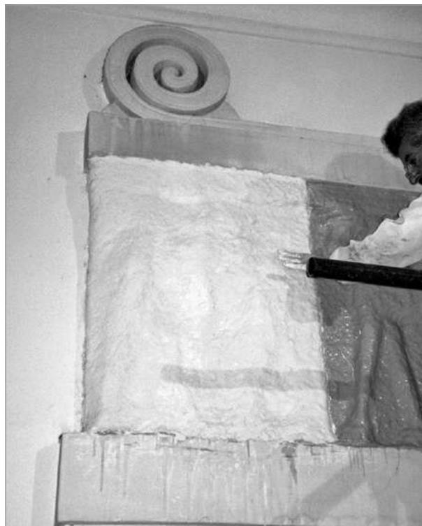
Fig. 25. Prima lastra. La resina caricata con fibre di vetro in fase di presa (foto Arch. S. Rizza).
