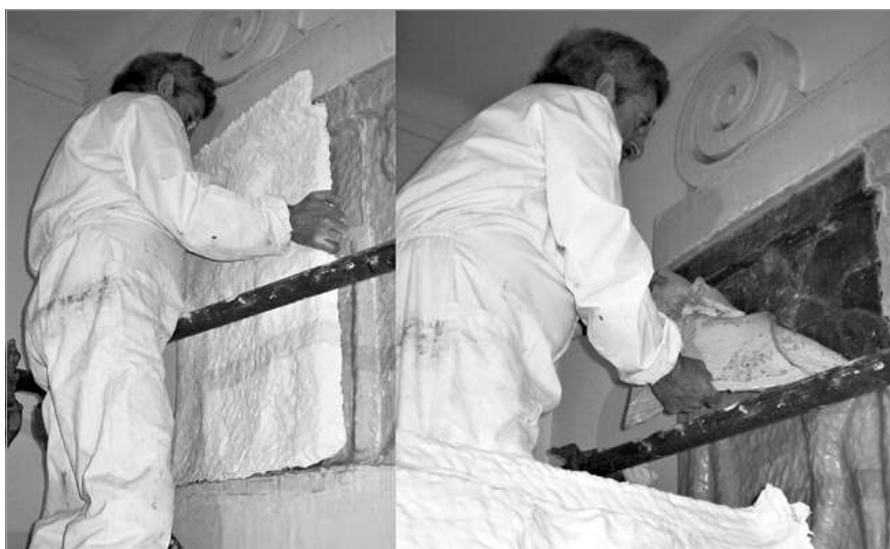
Fig. 26. Stacco del guscio esterno e rimozione della matrice in caucciù (foto Arch. S. Rizza).
