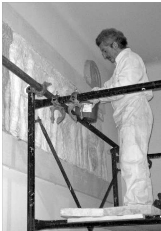
Fig. 24. Sesta lastra. Finitura del primo strato di resina (foto Arch. S. Rizza).
