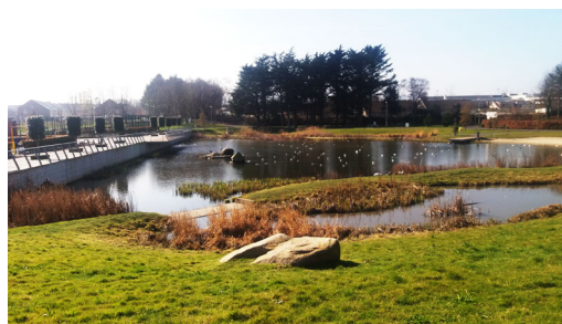
Figura 2 | Esempio di misura SuDS: stormwater retention lake in Dun Laoghaire, Dublin.
