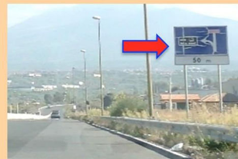
Segnaletica preesistente (strada senza sbocco) incoerente e fuorviante
