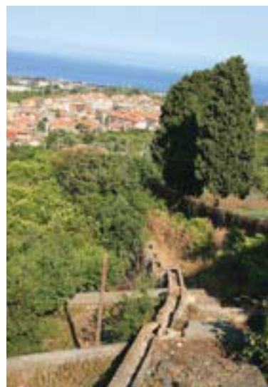
Impianto d'irrigazione su sistemazioni culturali a terrazza
