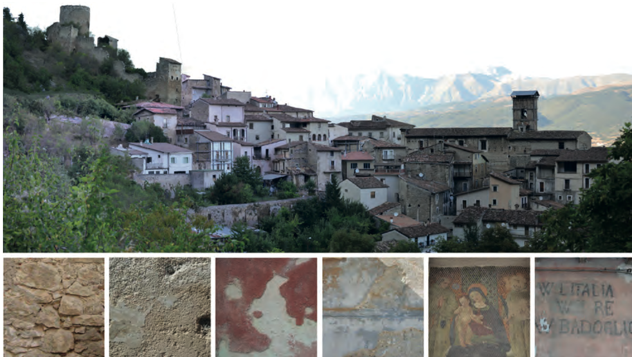
Fig. 3. L'abitato con la chiesa dell'Assunta sullo sfondo. Le coloriture si attestano sulle gamme chiare e la compresenza di tessiture murarie a vista e di paramenti intonacati deriva anche dalla gerarchizzazione delle diverse fronti degli edifici
