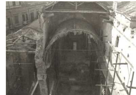
Figure 3. Rib vault in the church of St. Francis of Assisi in Palermo, revealed by the destruction caused by the 1943 bombings (Archive Soprintendenza per i Beni Culturali e Ambientali di Palermo. By courtesy of Assessorato regionale dei Beni Culturali e dell'Identità siciliana. Dipartimento regionale dei Beni Culturali e dell'Identità siciliana).
