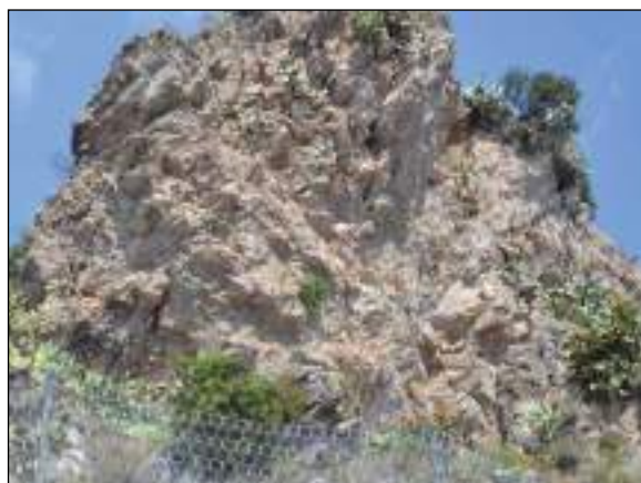
Figura 6 – Particolare ammasso ZO2. Si noti l'elevato grado di fratturazione.
