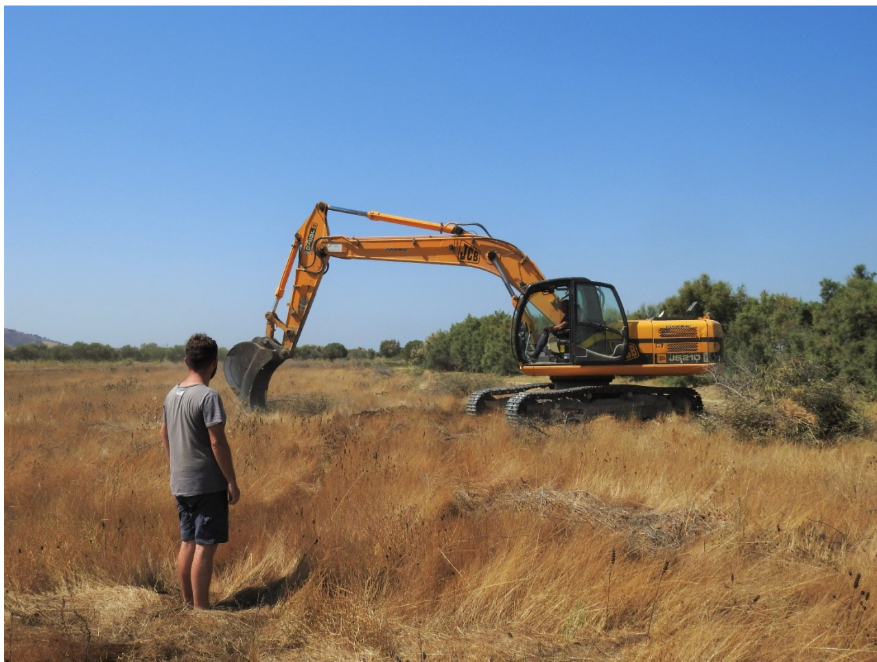
Fase di scavo per il posizionamento del sostegno (Foto: Davide Pepi).
