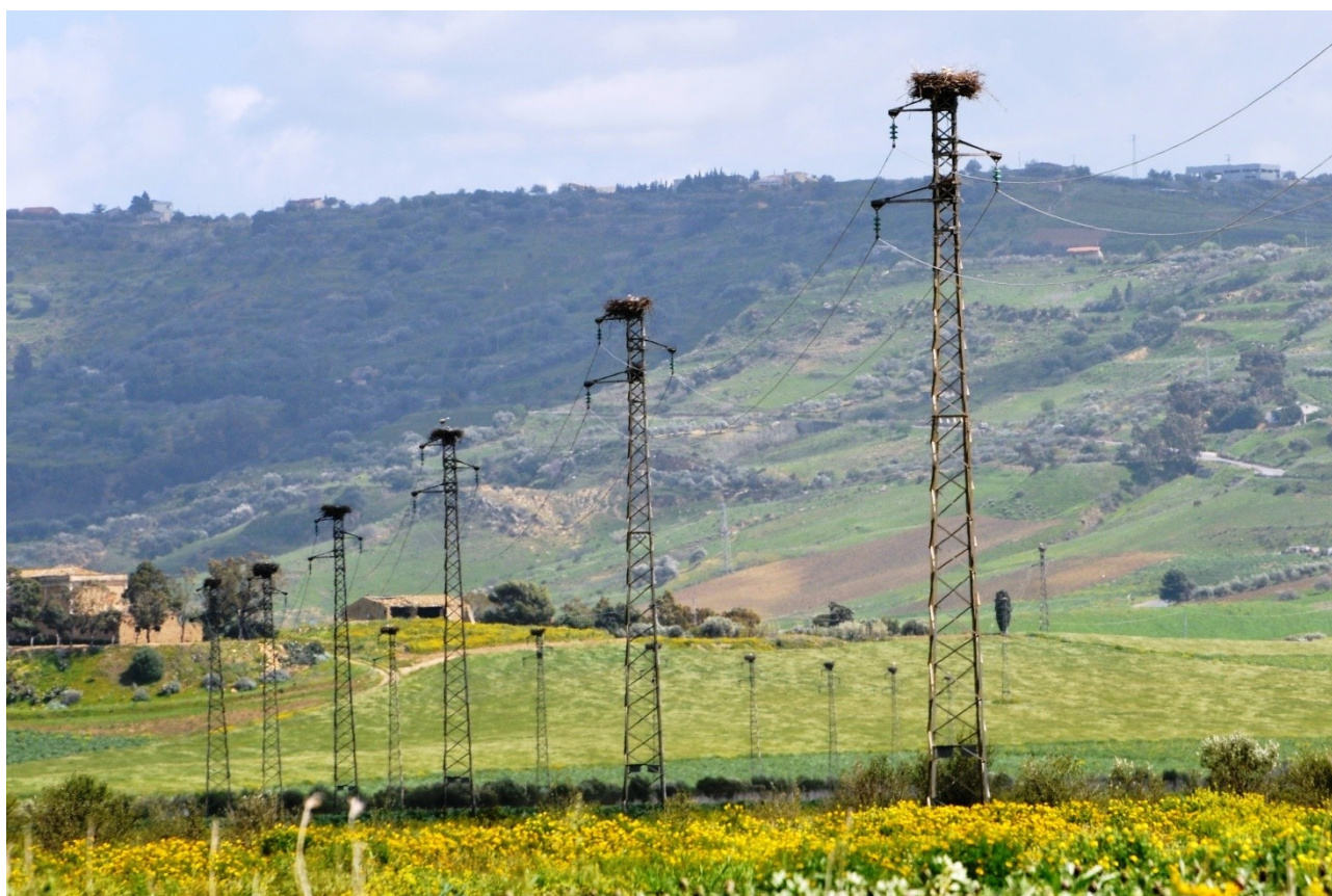
Fig. 24) Piana di Gela (contrada Scomunicata). In questa zona sarebbe utile posizionare piattaforme in legno in tralicci non ancora occupati dai nidi.
