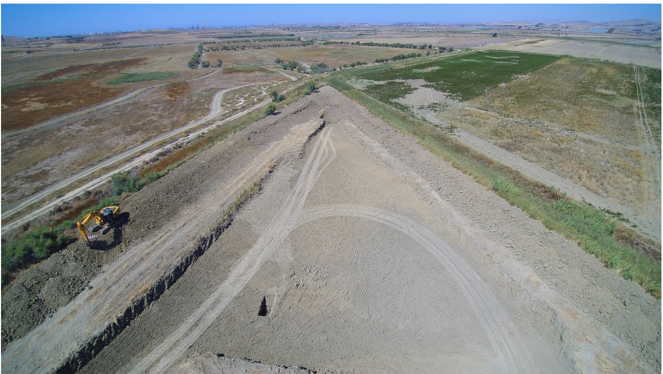
Fig. 43) Lavori di consolidamento degli argini della zona umida denominata “acquitrino delle pavoncelle” (Foto: Andrea Parisi).
