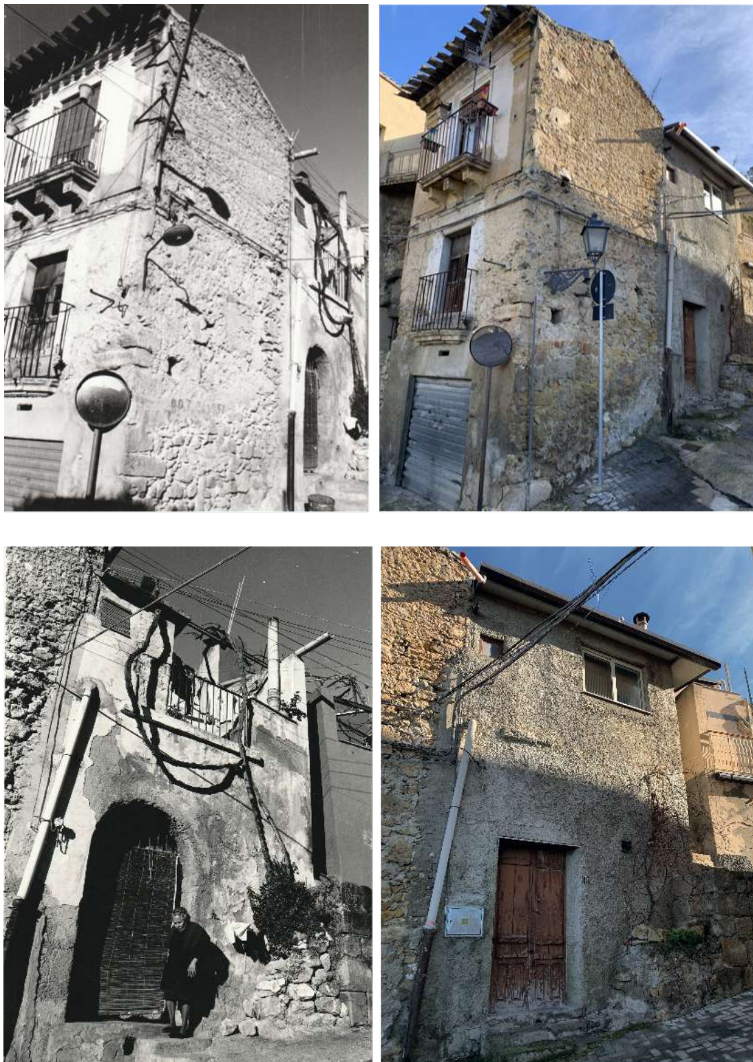
Fig. 3.19. Esempio di trasformazione recente lungo la via Sparterra; confronto tra una fotografia storica (da NIGRELLI 2001, p. 18) e lo stato attuale. La foto mostra la seconda fase di trasformazioni rilevabili in un'unità edilizia a ridosso della via Sottarco. Si rilevano modifiche alla volumetria tramite chiusura del terrazzo e all'originaria apertura ad arco a tutto sesto.
