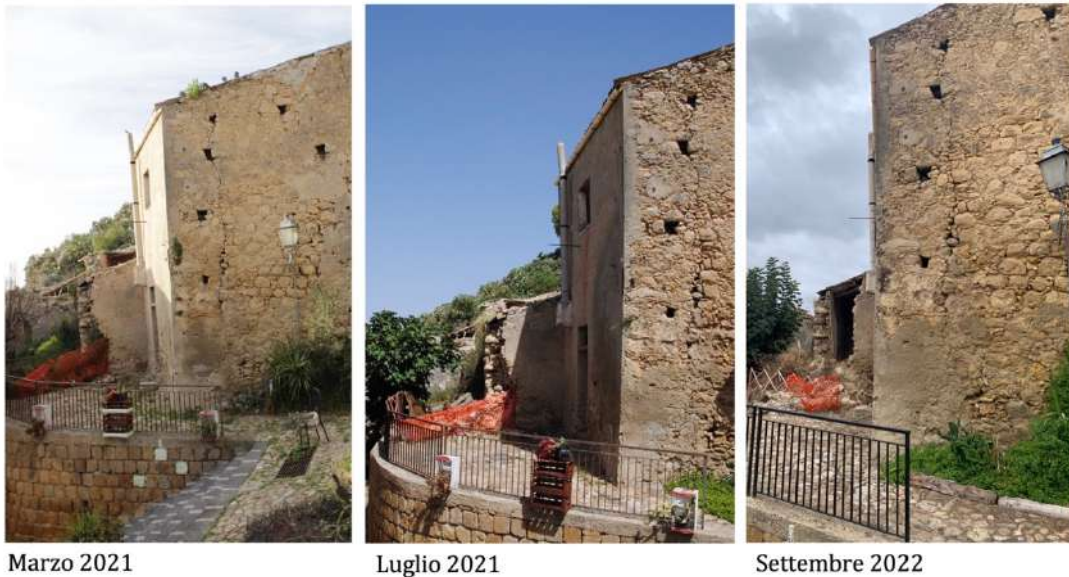
Fig. 3.43. Avanzamento dei crolli dell'angolata di una cellula contigua a un rudere
