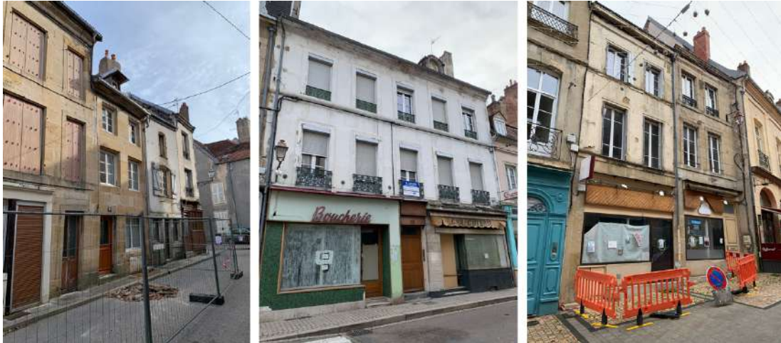
Fig. 4.29. A sinistra: Langres, chiusura di un tratto della Rue Walferdin in seguito a un crollo. Al centro e a destra: Autun, commerci e abitazioni abbandonate lungo la rue Guérin e chiusure lungo la Rue Chauchien a causa di immobili pericolanti.
