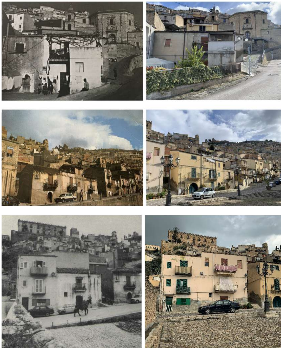
Fig. 3.18. Permanenze e mutazioni nel corso dell'ultimo secolo lungo la via Granfonte. In alto: il confronto tra una fotografia storica (da NIGRELLI 2001, p.18) e lo stato presente mostra solo piccole alterazioni delle bucatore. Al centro: il confronto tra una cartolina storica (archivio G. Nigrelli) e la fotografia attuale mostra modifiche nella consistenza attraverso l'aggiunta di sopraelevazioni e terrazzi. In basso: il confronto tra una fotografia storica (reperita da facebook.com) e lo stato presente evidenzia non solo la sopraelevazione, ma anche significative modifiche alle aperture e ai balconi.
