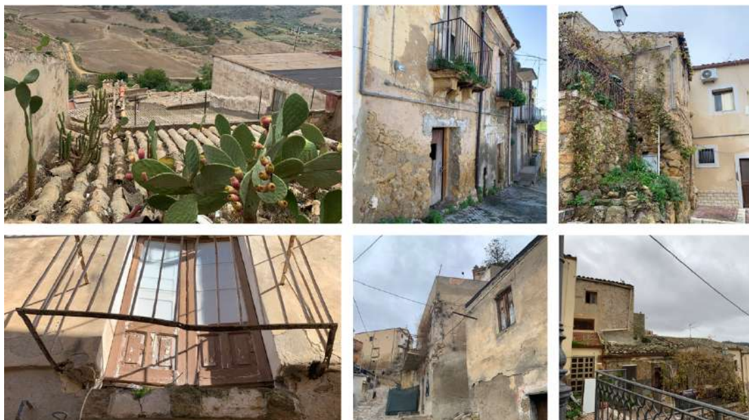
STATO DI CONSERVAZIONE DELLE U.E. IN ABBANDONO E VUOTE
