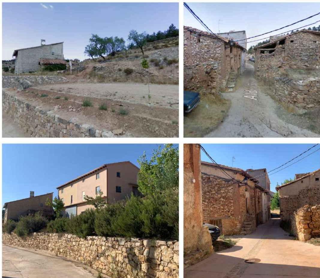
Fig. 4.39. Confronto tra Lo Street View di Google maps (2008) e la situazione al 2021. A destra: nuova costruzione in un'area edificabile secondo le Normas Subsidiarias (o complementarias) de Planeamiento; a destra: interventi di rifacimento e sopraelevazione delle coperture con tecniche non compatibili.
