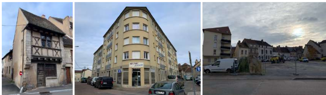
Fig. 4.31. Autun, il quartiere Marchaux è caratterizzato da edifici di varia tipologia, di origine medievale e contemporanea. Le demolizioni in corso interessano le aree in stato di decadimento.
