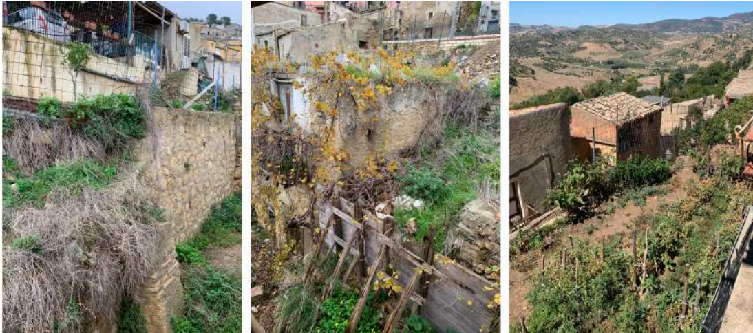
Fig.3.37. Intervento di parziale demolizione e messa in sicurezza lungo tra Vico Vitale e via Riscato. A sinistra e al centro: la situazione a valle mostra il puntellamento provvisorio e la parziale ricostruzione del muro di sostegno; a destra: situazione a monte con l'utilizzo dell'area frutto di riempimento come orto privato.
