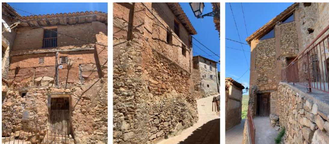
Fig. 4.40. Prospetto esterno dell'edificio in seguito al restauro.
