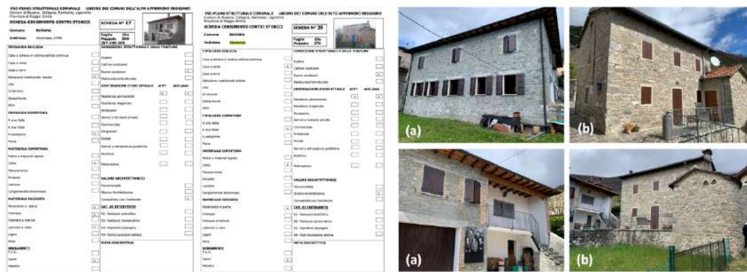
Fig. 4.19. Nismozza, complesso di tre edifici con relativa scheda di censimento (da UNIONE COMUNI DELL'ALTO APPENNINO REGGIANO 2019). La disposizione è a corpi separati e consiste nella stalla-granaio (a) e nella casa a corte e forno (b). L'edificio originariamente adibito a stalla-granaio (identificato nella scheda come abitazione tradizionale isolata) è oggi un'abitazione ed è stato oggetto di notevoli trasformazioni: dopo una prima sopraelevazione nei primi decenni del Novecento, ha subito un ampliamento e una ristrutturazione con sostituzione degli orizzontamenti originari e introduzione di un garage. Attualmente, l'antico forno è destinato a servizio igienico, la stalla granaio è identificata come edificio privo di valore storico e sottoposta a ristrutturazione edilizia, mentre al complesso della casa a corte con forno annesso è riconosciuto un valore storico-architettonico e se ne prevede il restauro e risanamento conservativo.
