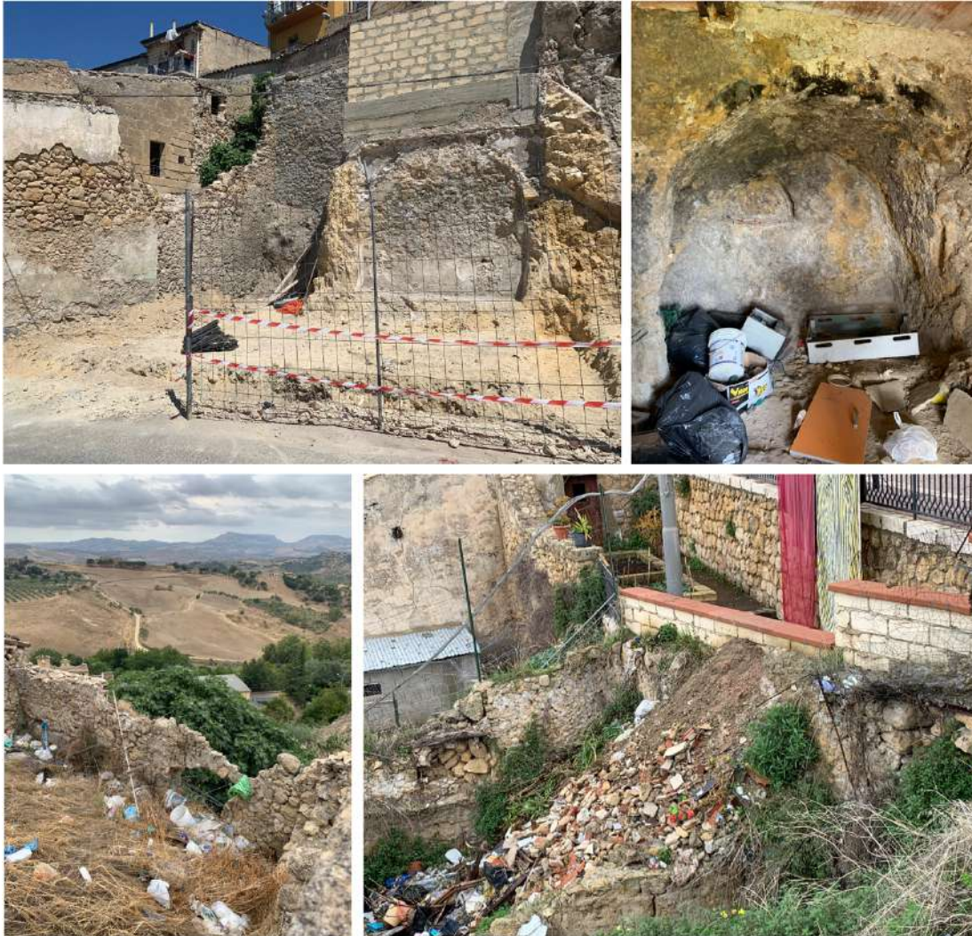
Fig. 3.39. Gli effetti sul costruito scaturiscono da diversi atteggiamenti. In alto a sinistra: demolizione del 2020 di edificio con ambiente voltato lungo la via Granfonte. In alto a destra e in basso: utilizzo degli edifici abbandonati e dei ruderi come luoghi di scarto.
