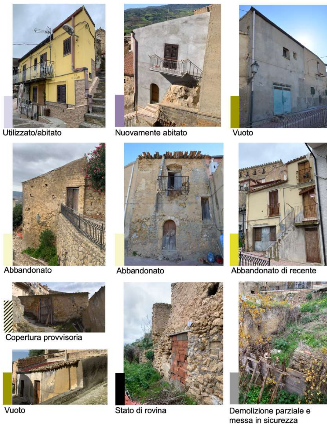
Fig. 3.16. Ricognizione degli edifici secondo lo stato d'uso e di conservazione da cui emerge una forte disomogeneità di condizioni riscontrabili nel quartiere storico. Si rimanda alla planimetria della figura a pagina seguente per una lettura della distribuzione di ciascuna delle condizioni individuate.
