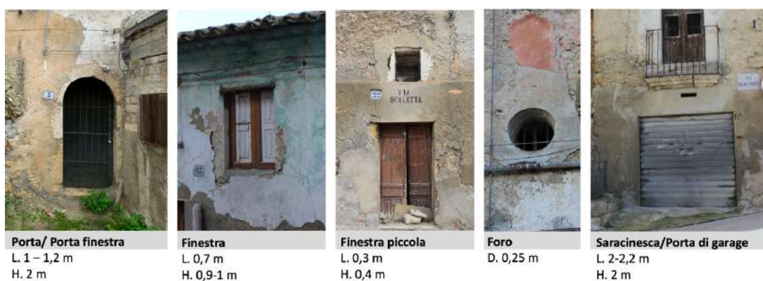
Fig. 3.52. Identificazione di dimensioni standard ai fini del calcolo della superficie finestrata.
